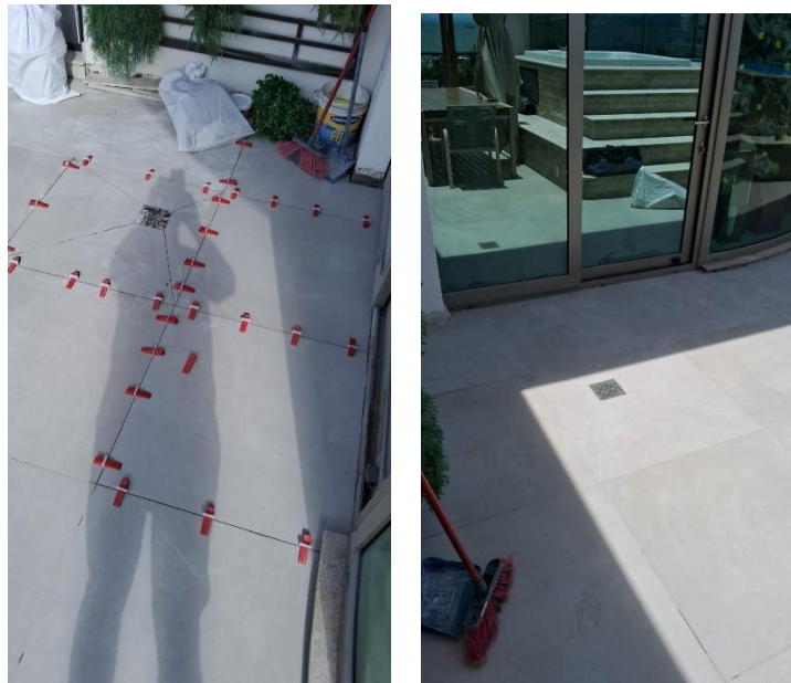
Figura 54: Reinstalação do piso na região
