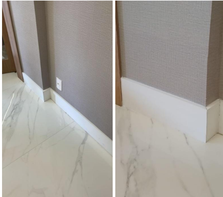
Figura 37: Instalação dos novos rodapés
