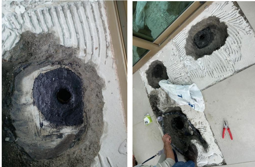
Figura 49: Região após retirada do piso e aplicação de nova manta
