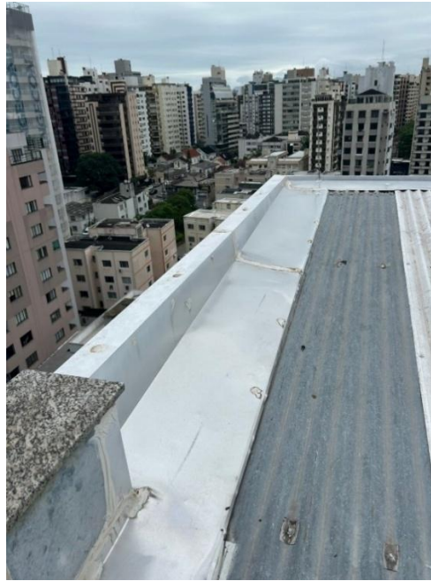
Figura 24: Rufo em U instalado no telhado por cima da placa cimentícia
