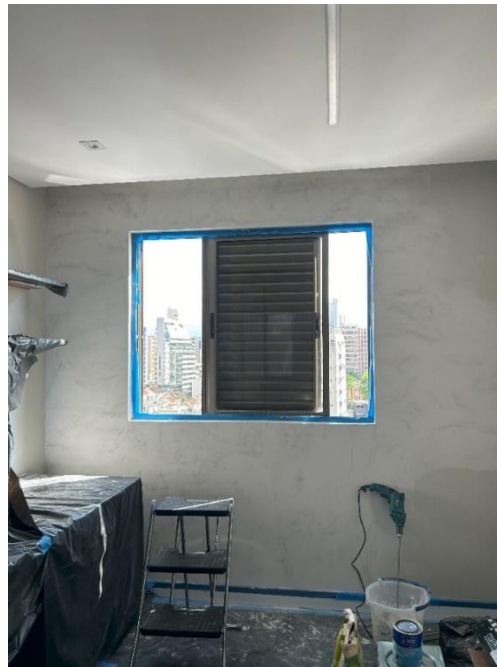
Figura 27: Parede do escritório com fundo preparador
