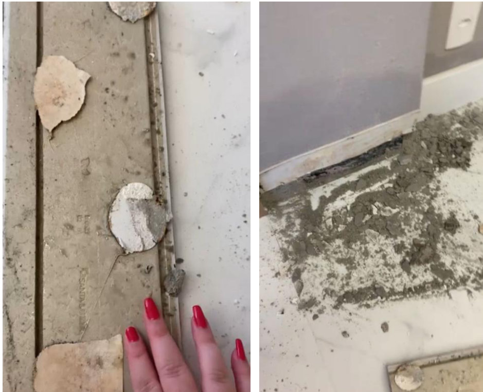
Figura 33: Retirada do rodapé e reboco do pilar
