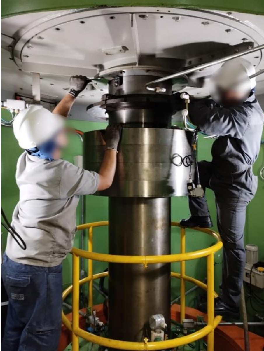
Figura 24 - Centralização da tampa inferior do MGI
