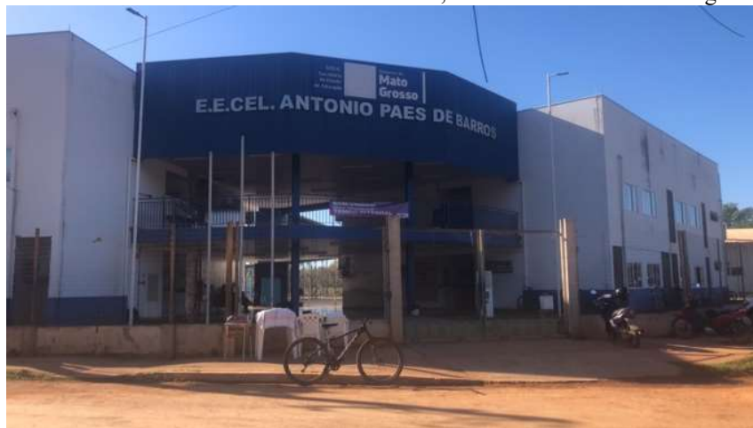
Figura 22: Fachada da Escola Antônio Paes de Barros, no centro de Barão de Melgaco.
