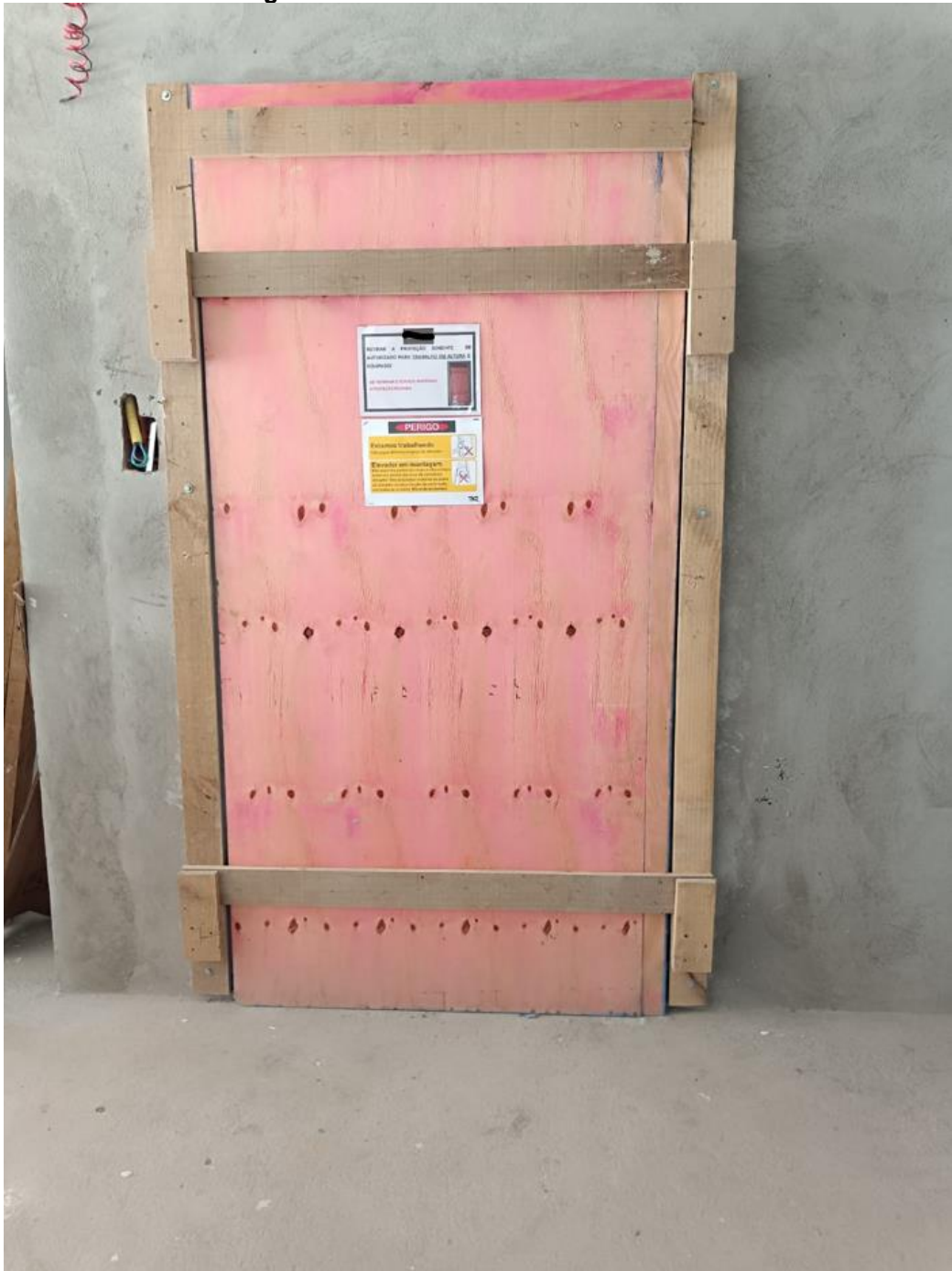
Figura 12 – Acesso ao fosso do elevador
