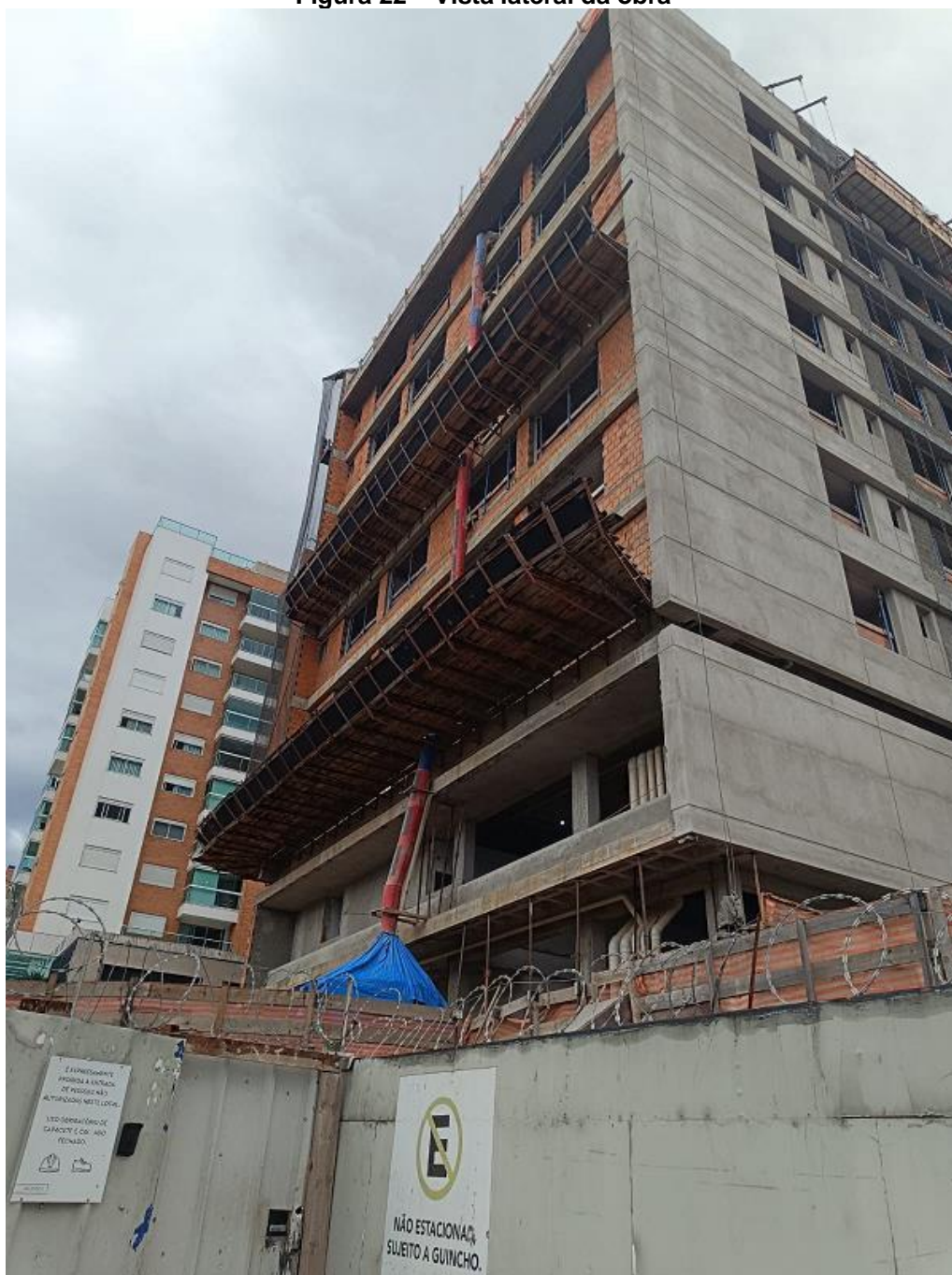
Figura 22 – Vista lateral da obra
