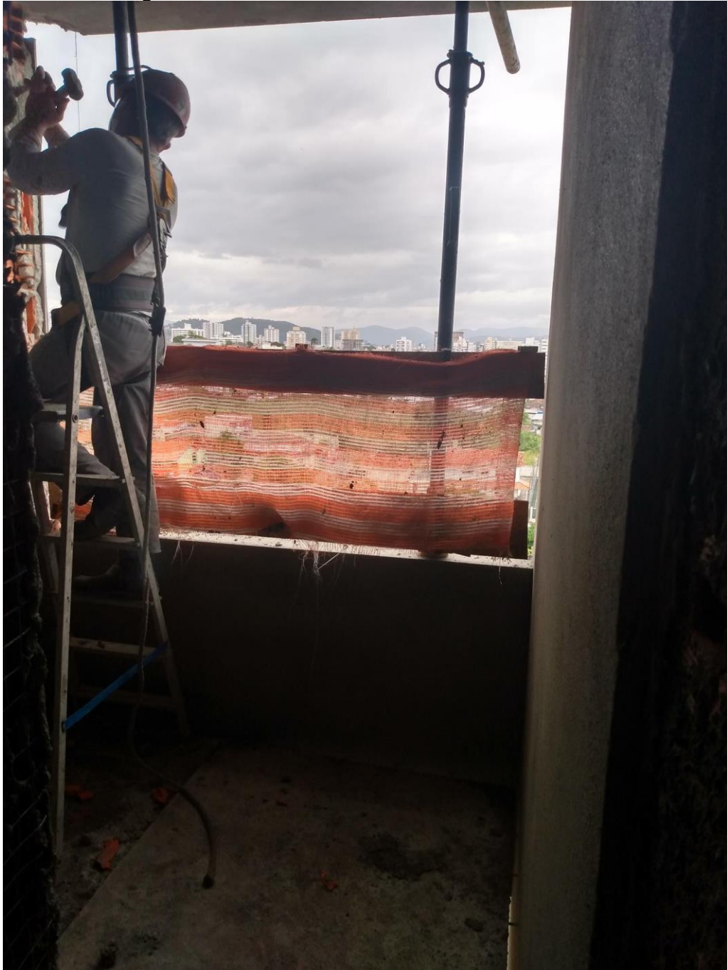
Figura 19 – Trabalhador realizando trabalho em altura
