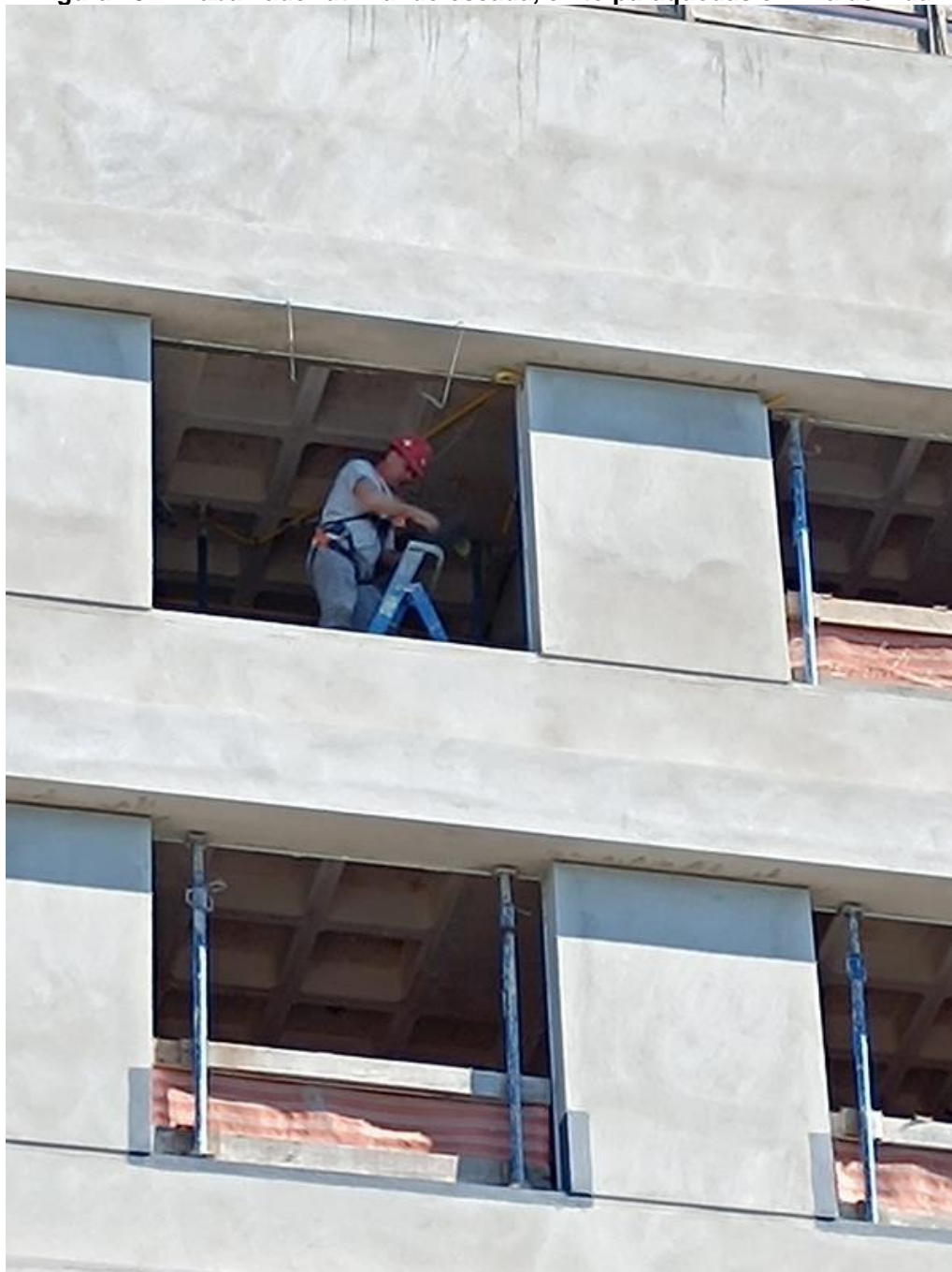
Figura 20 – Trabalhador utilizando escada, cinto paraquedas e linha de vida
