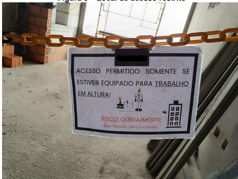
Figura 9 – Local de acesso restrito
