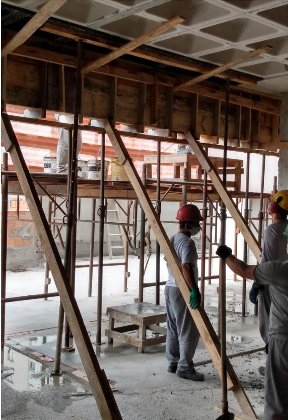
Figura 4 – Trabalhadores usando EPI's
