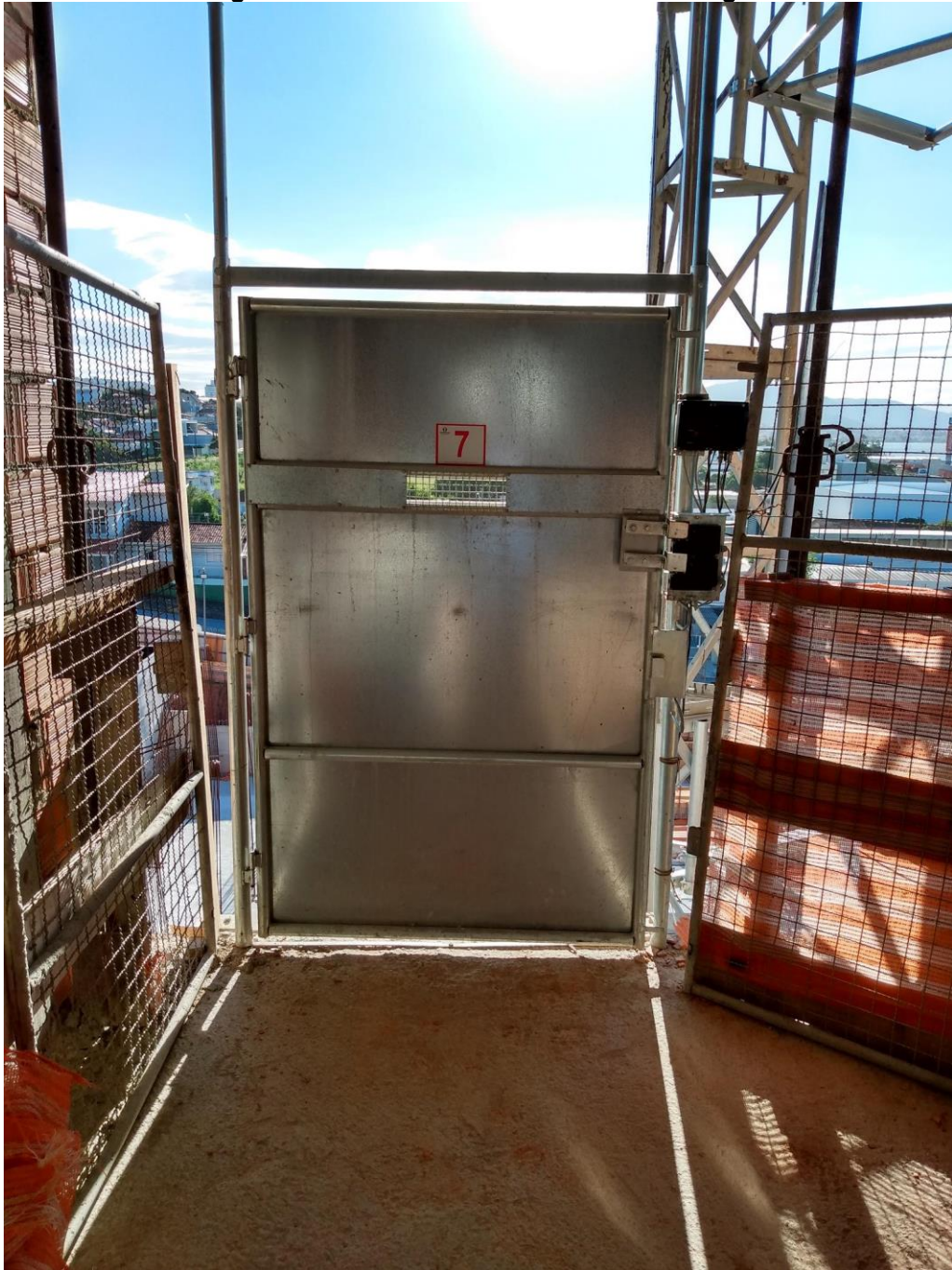
Figura 15 – Vista interna do elevador de carga
