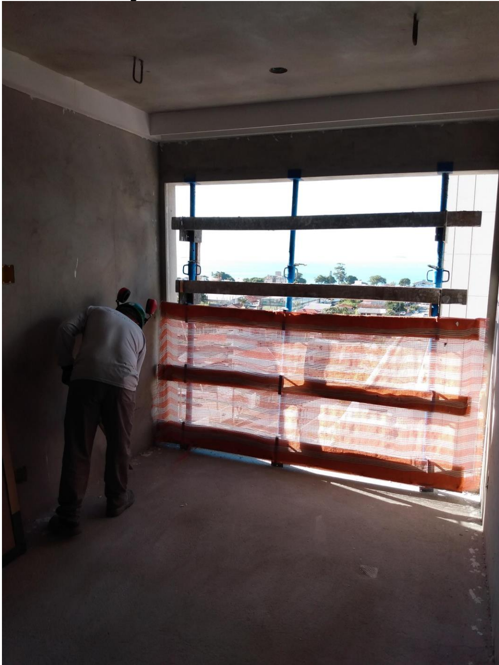
Figura 23 – Trabalhador utilizando os EPI's
