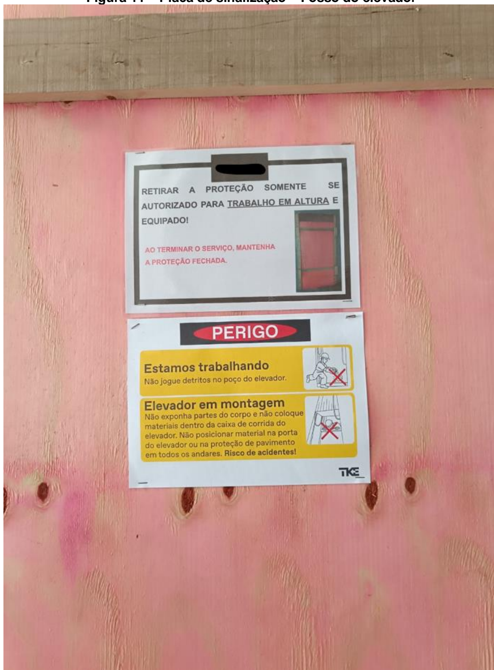
Figura 11 – Placa de sinalização – Fosso do elevador
