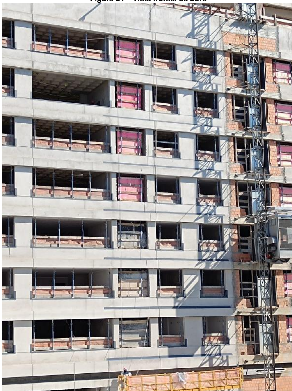
Figura 24 – Vista frontal da obra
