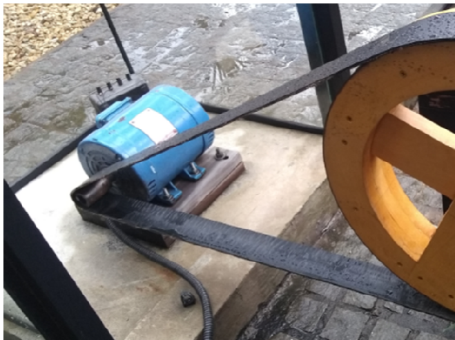
Figura 19 – Gerador acionado no final do sistema.
