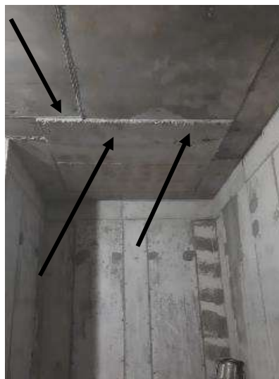
Figura 24 – Forma deslocada: a) na laje, b) na parede.
