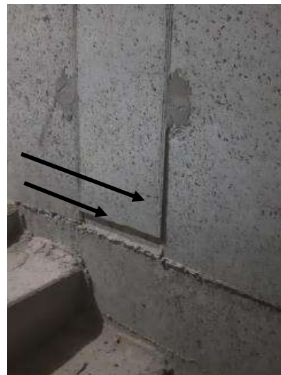
Figura 24 – Forma deslocada: a) na laje, b) na parede.
