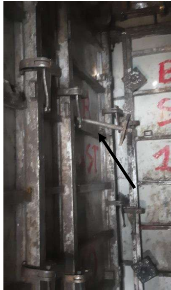
Figura 29 – Forma com travamento incompleto
