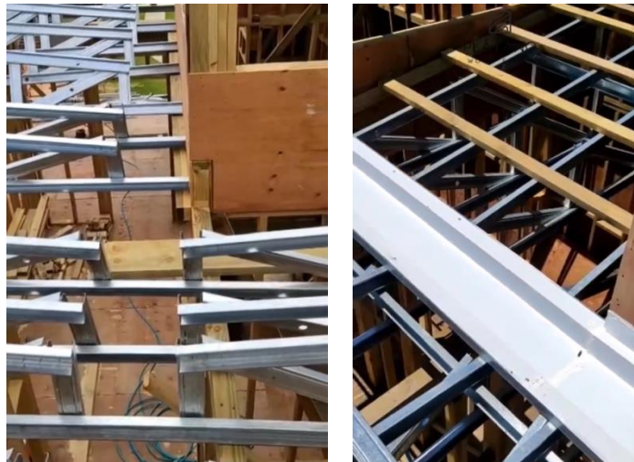
Figura 80 - Montagem de calhas
