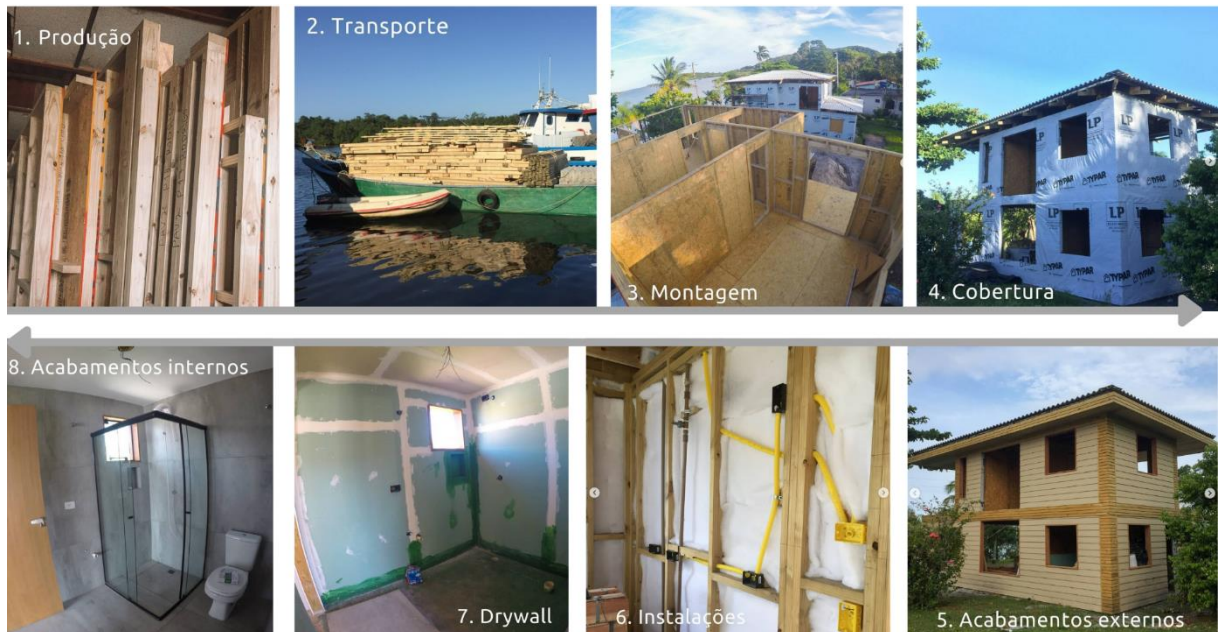
Figura 48 - Etapas da construção realizada em 2020 pela Empresa C
