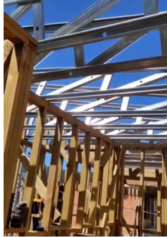
Figura 79 - Telhado metálico pré-fabricado
