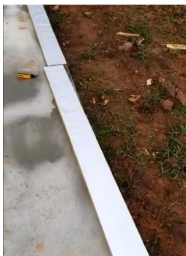
Figura 67 - Fita metálica utilizada para proteger ossatura de madeira das paredes
