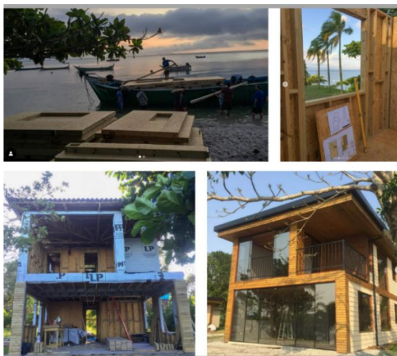
Figura 47 - Construção executada pela Empresa C em praia do Paraná em 2020
