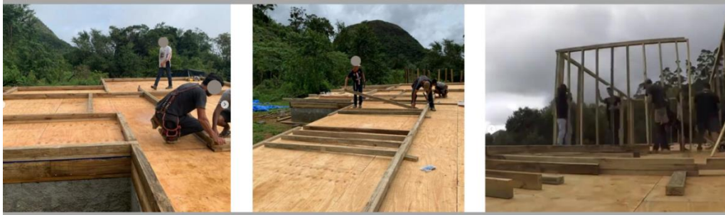
Figura 35 - Execução de paredes da Empresa A
