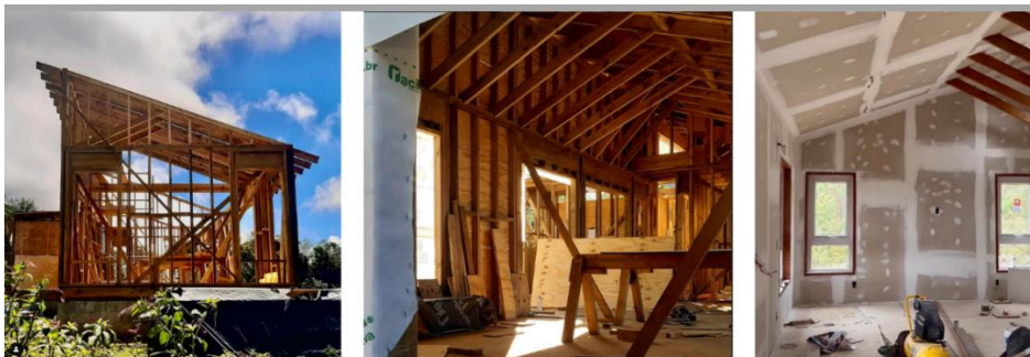
Figura 38 - Projeto em execução
