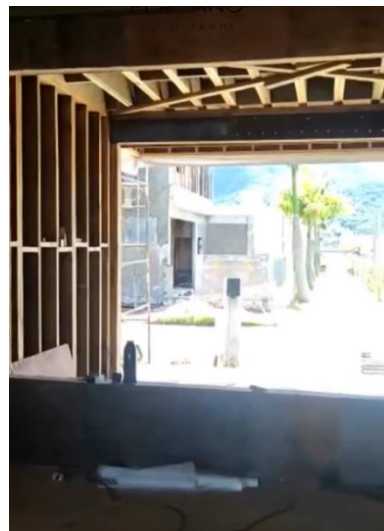
Figura 78 - Travamento de peças de entrepiso
