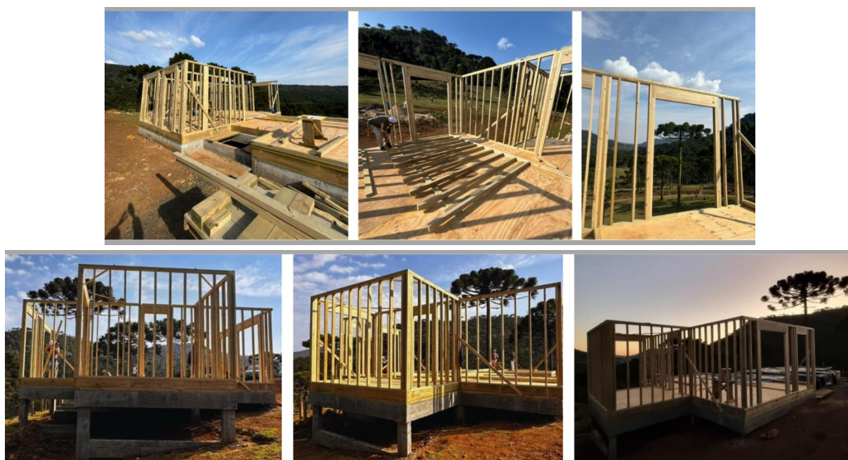
Figura 58 - Construção no local executada pela empresa E em Santa Catarina em 2024
