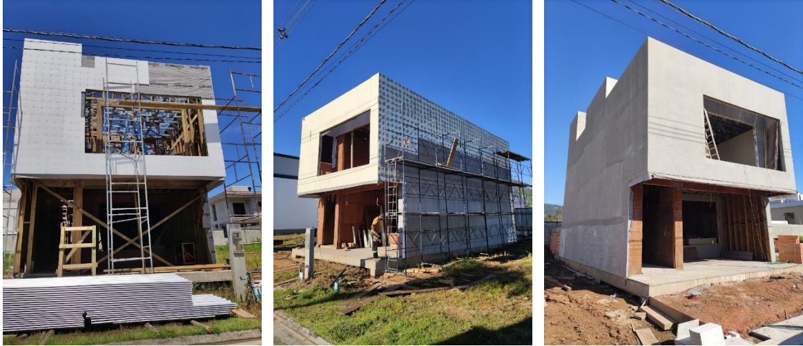
Figura 71 - Fechamento externo com sistema EIFS
