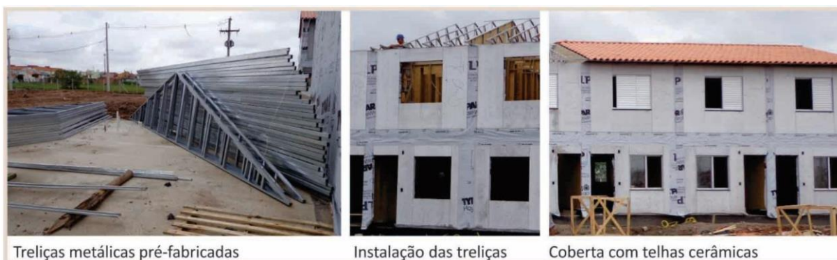
Figura 26 - Cobertura do Residencial Haragano, com treliças metálicas e telhas cerâmicas
