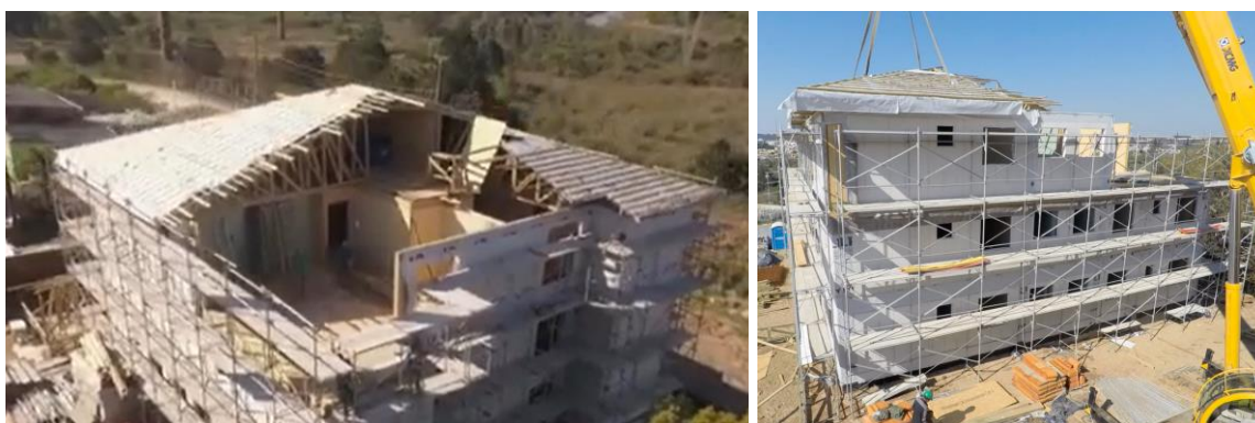
Figura 27 - Cobertura do primeiro prédio em wood frame , com treliças em madeira
