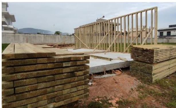
Figura 65 - Madeiras empilhadas para a construção
