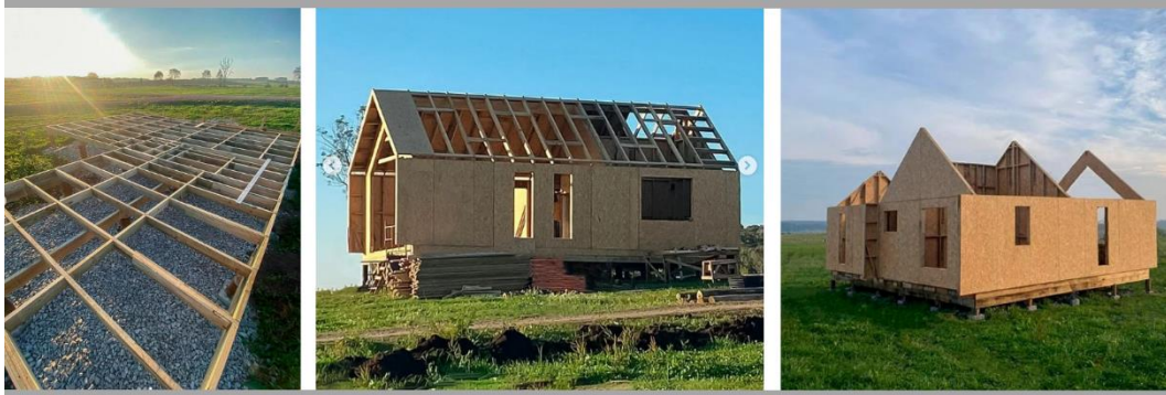
Figura 52 - Construção de uma cabana da Empresa C no canteiro de obras
