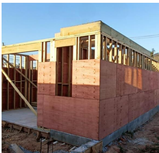
Figura 69 - Instalação das chapas de compensados de 12mm nas paredes externas
