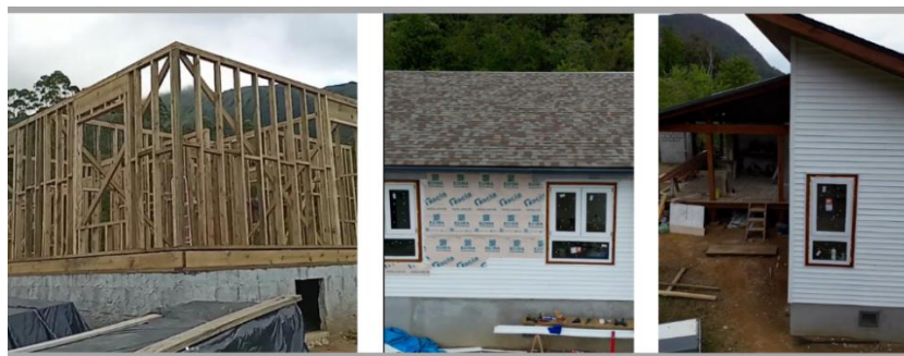
Figura 36 - Ossatura em madeira, membrana hidrófuga e sidings da Empresa A
