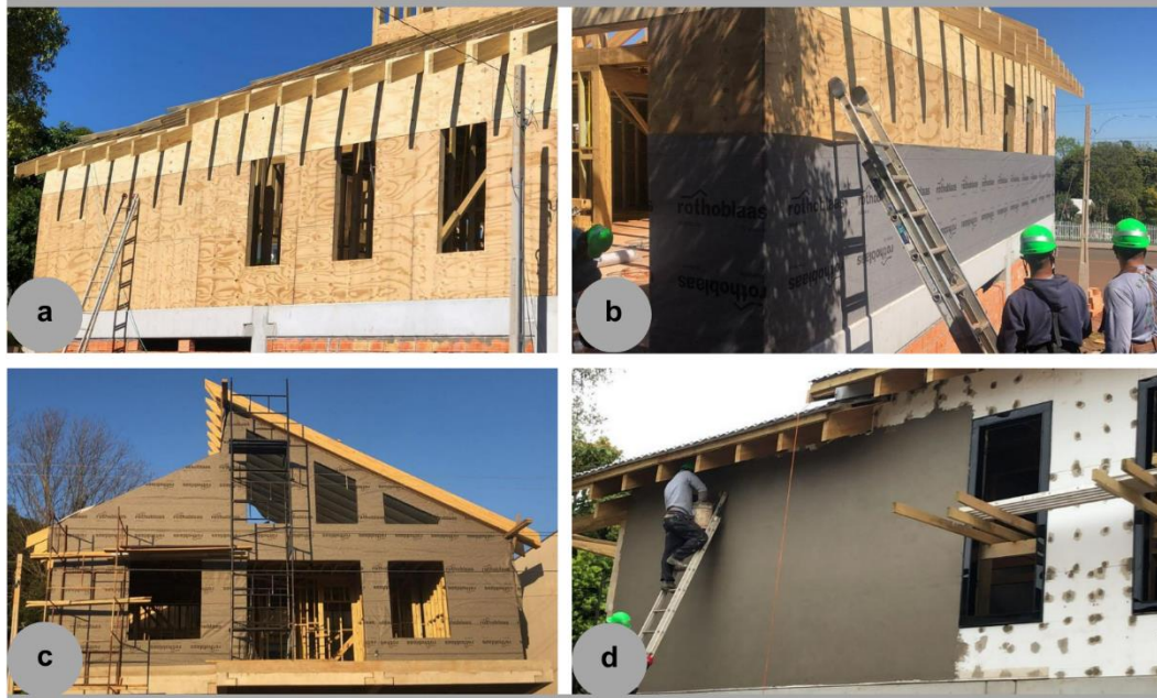
Figura 43 - Fechamento externo com sistema EIFs da Empresa B
