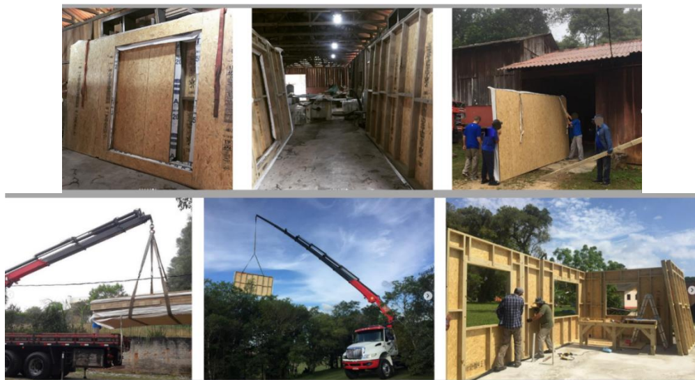
Figura 51 - Processo de fabricação de painéis de parede da Empresa C
