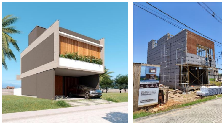
Figura 61 - Projeto 3D e construção da edificação do estudo de caso
