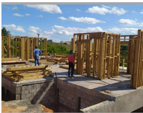
Figura 57 - Construção em andamento pela empresa D
