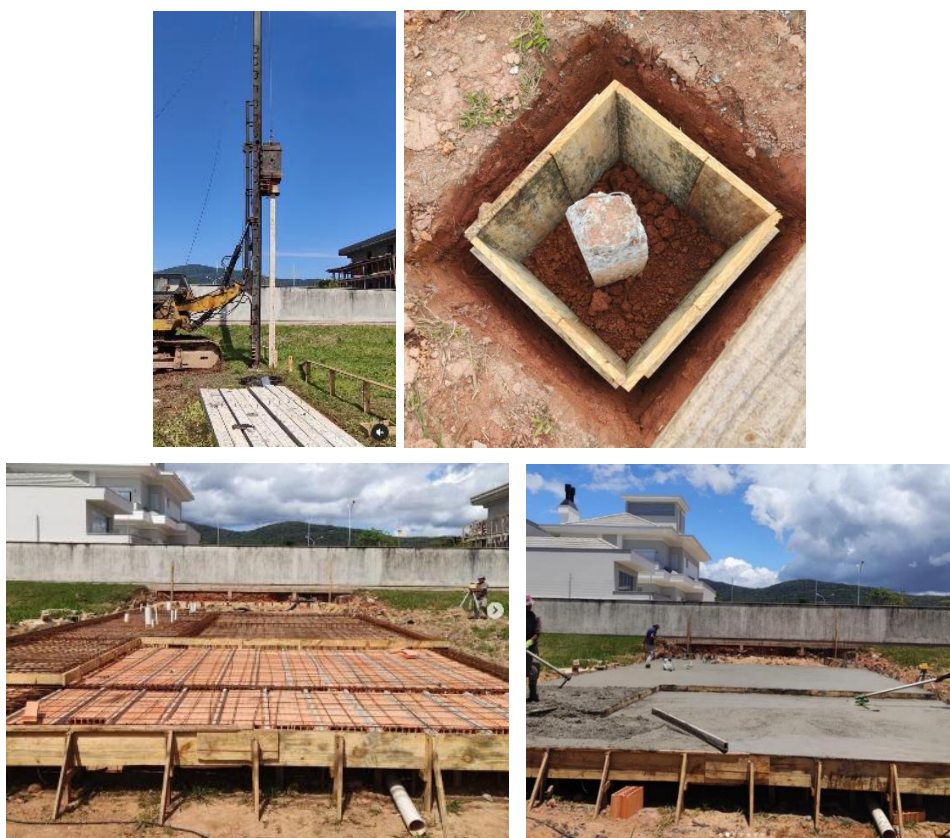
Figura 64 - Fundação com blocos de estaca e laje concretada
