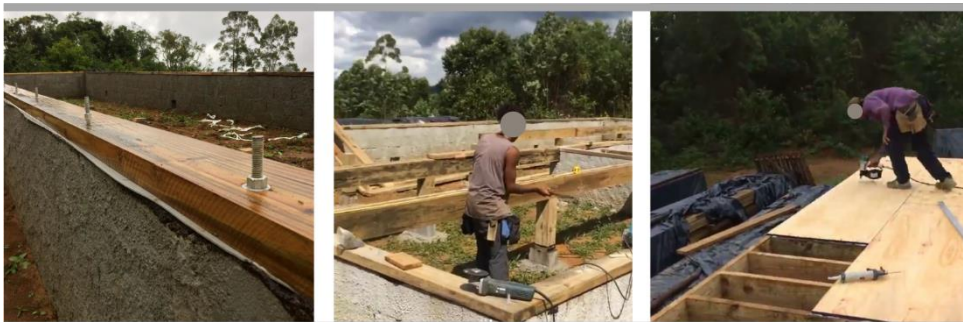
Figura 34 - Execução de piso da Empresa A
