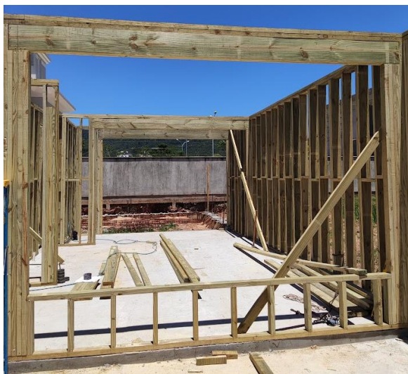
Figura 68 - Ossatura de parede com abertura para esquadria
