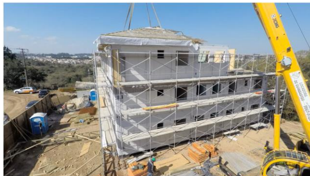
Figura 20 - Primeiro prédio em wood frame no Brasil, no Paraná
