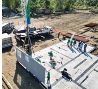
Figura 33 - Métodos de construção: no local (a), por painéis pré-fabricados (b) e modular (c)
