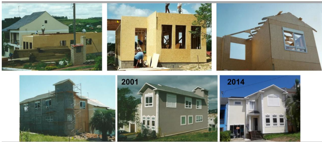
Figura 55 - Primeira construção em 2001 realizada pela empresa D
