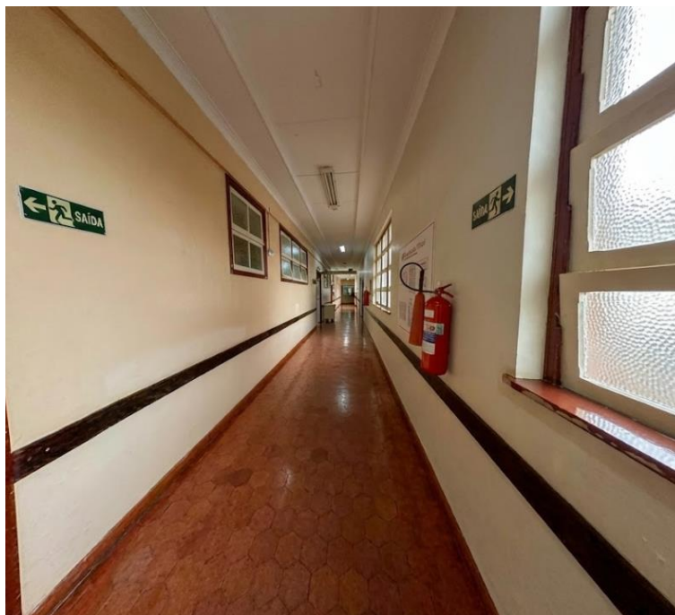
Figura 7 – Corredores com Ausência de Barreira Física de Compartimentação
