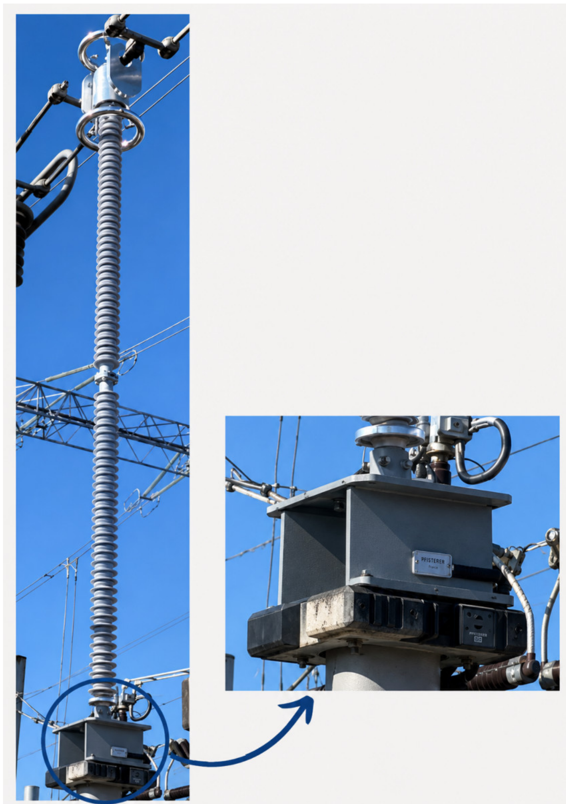
Figura 12 – Lote piloto do TECO na SE YTÁ
