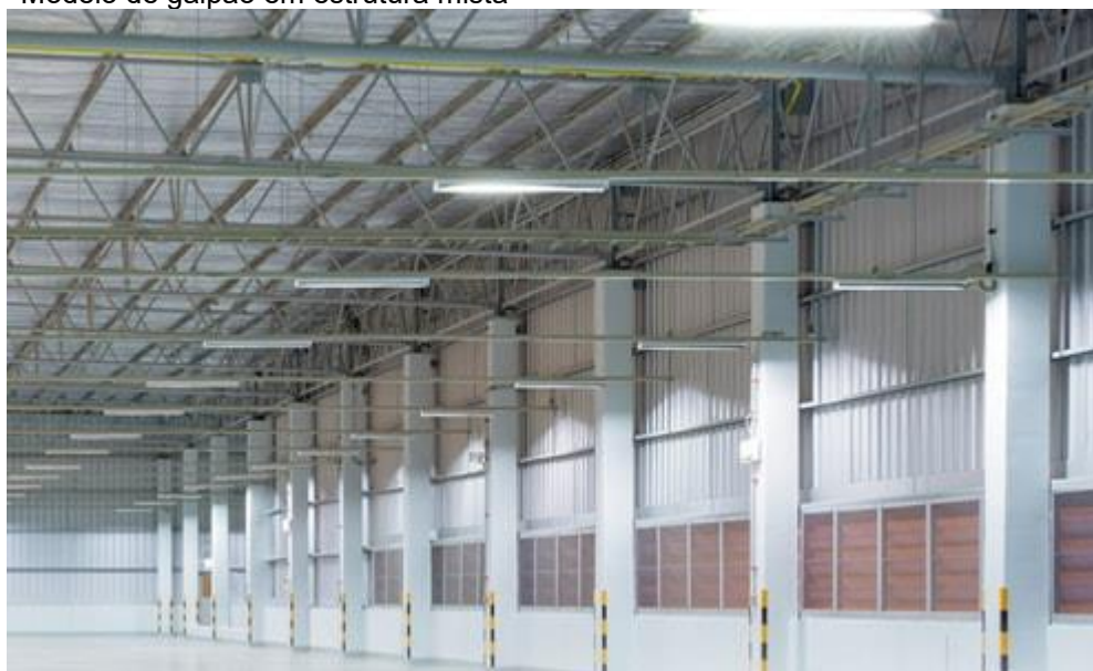
Figura 4 - Modelo de galpão em estrutura mista
