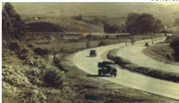
a) Obra via Anhanguera até Jundiá nos anos 50 [ENGEMIX, 2018].
