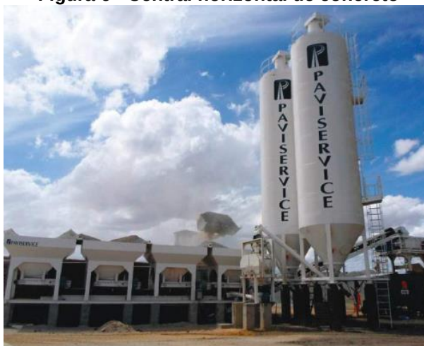
Figura 6 - Central horizontal de concreto
