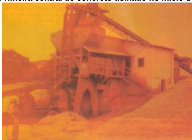
Figura 2 - Primeira central de concreto usinado no início dos anos 50
