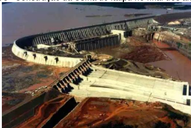
Figura 3 - Construção da Usina de Itaipu no final dos anos 70
