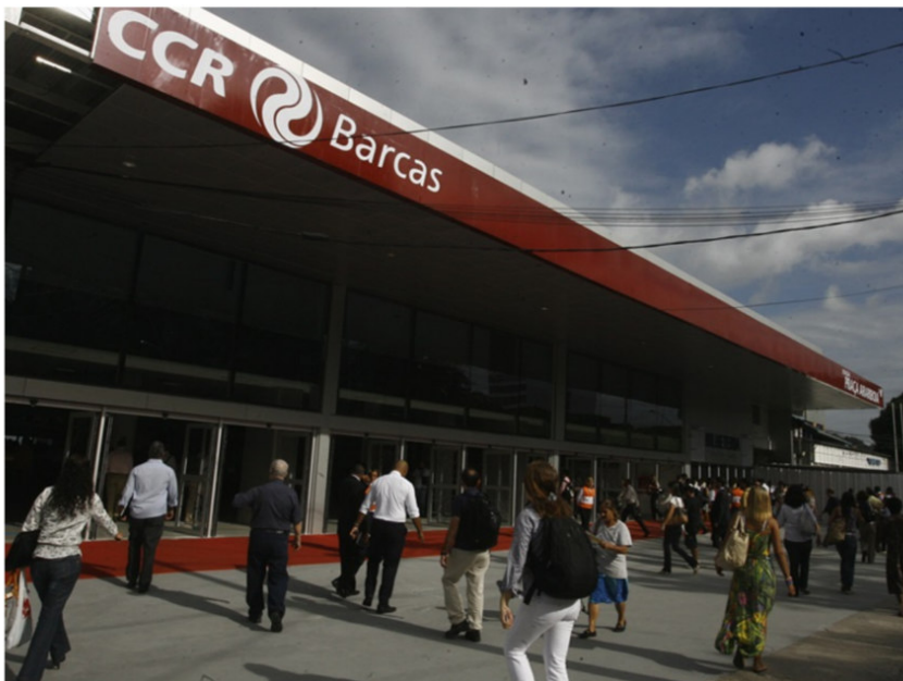
Figura 24 - Fachada da Estação Aquaviária Praça Arariboia
