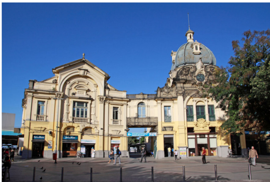
Figura 23 - Fachada da Estação Aquaviária Praça XV
