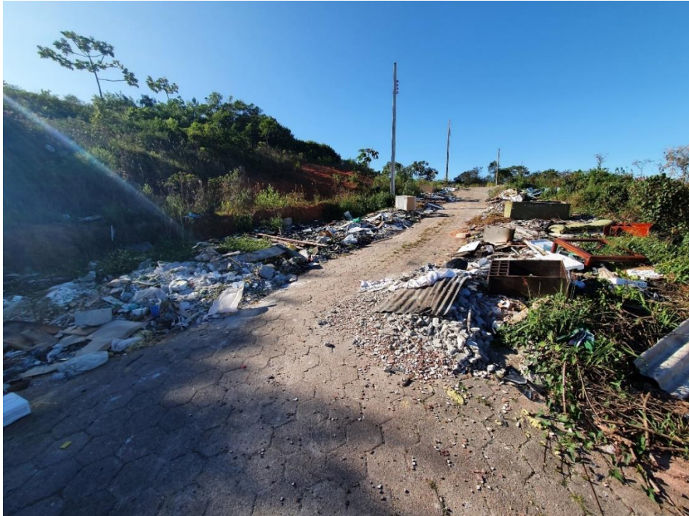
Figura 18 - Ponto 11 de disposição irregular
