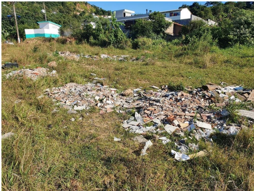
Figura 18 - Ponto 08 de disposição irregular
