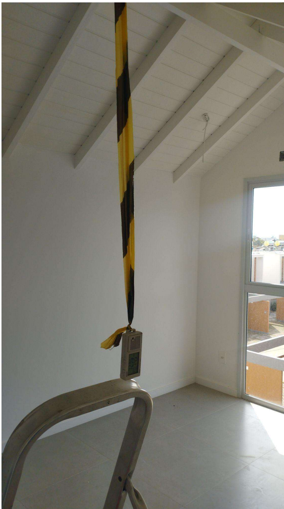
Figura 15 - Sótão casa em parede de concreto.
