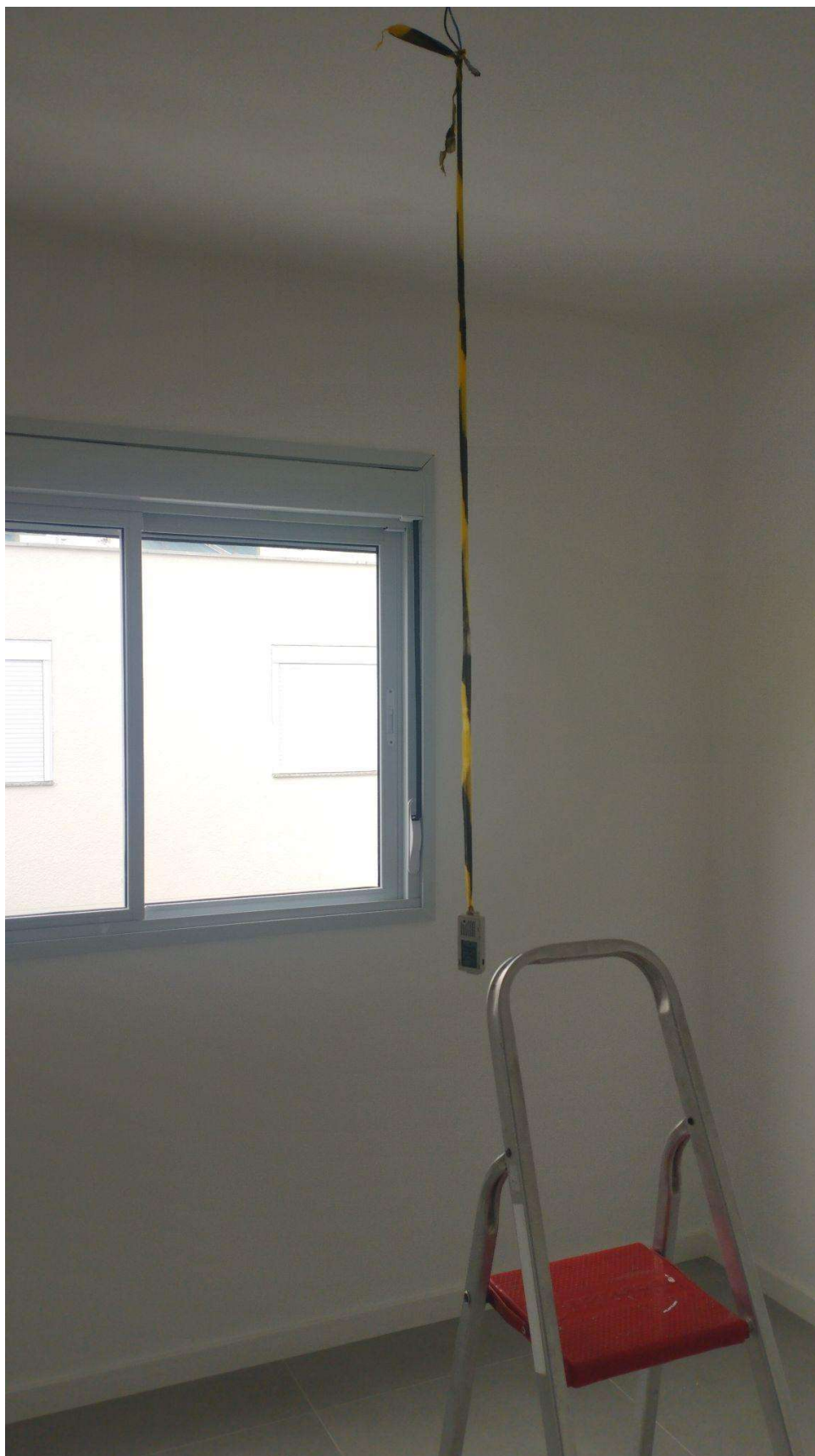
Figura 14 - Quarto sul casa em parede de concreto.
