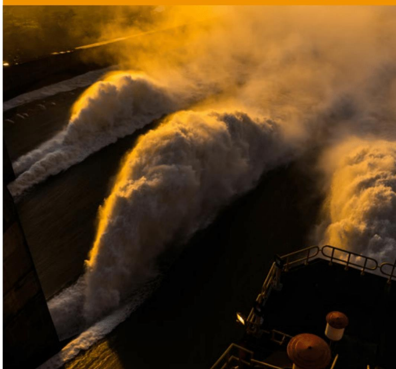
Usina Hidrelétrica de Itaipu – vertedouro. Foto: Alexandre Marchetti / Acervo Itaipu Binacional
