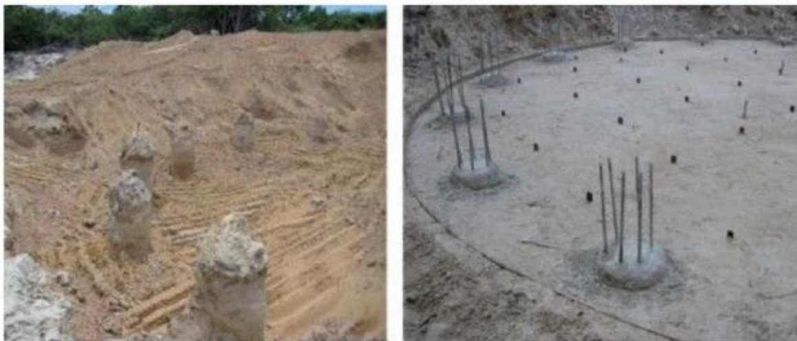
Figura 12. Estacas de hélice contínua após execução (esquerda) e após arrasamento (direita).
