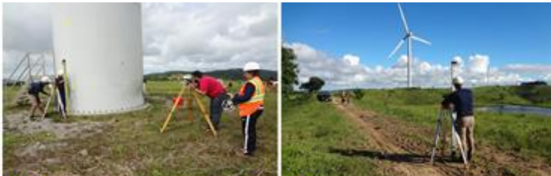
Figura 46. Auscultação geodésica com equipamentos topográficos de alta precisão em torres eólicas.
