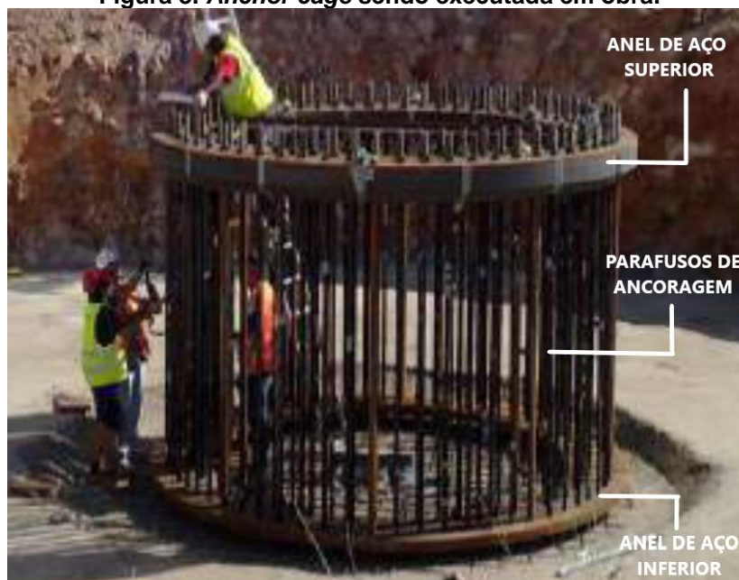
Figura 8. Anchor cage sendo executada em obra.
