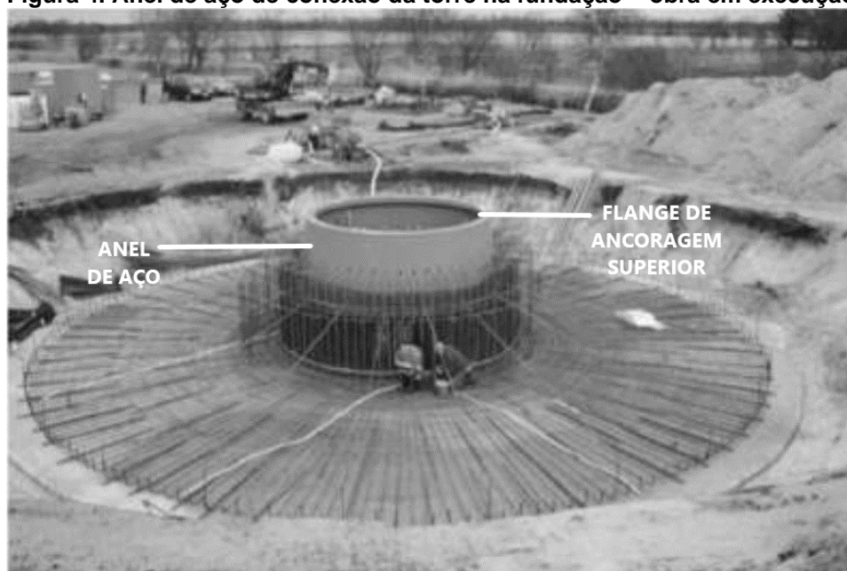
Figura 4. Anel de aço de conexão da torre na fundação – obra em execução.
