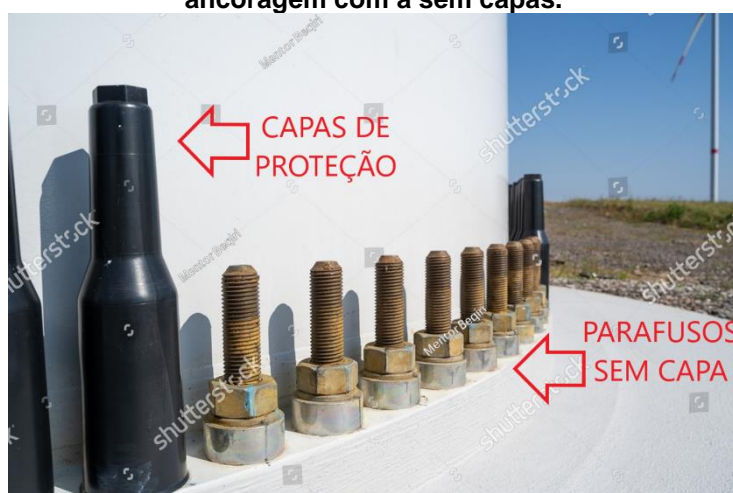
Figura 39. Porção externa da fundação – parafusos de ancoragem com e sem capas.
