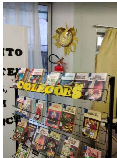
Figura 16 – Extintor no espaço infanto-juvenil sem sinalização e com pouca visibilidade, além de materiais acima
