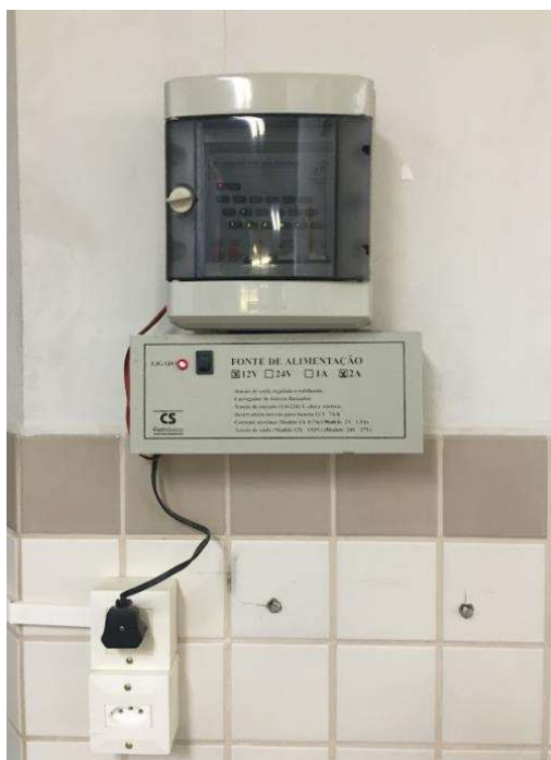
Figura 35 – Central de alarme do tipo convencional, no corredor de circulação do térreo
