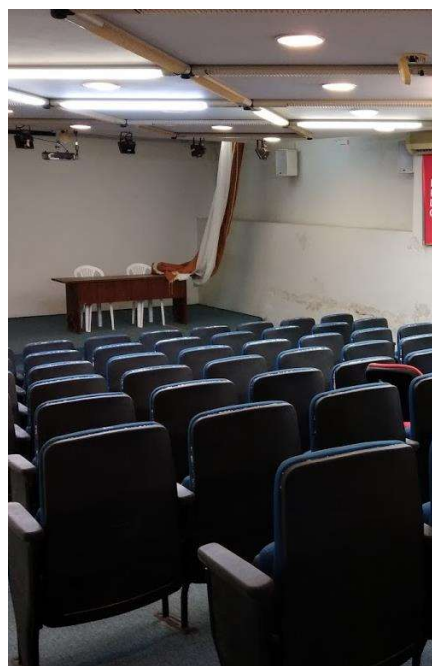
Figura 38 – Detectores de fumaça no auditório
