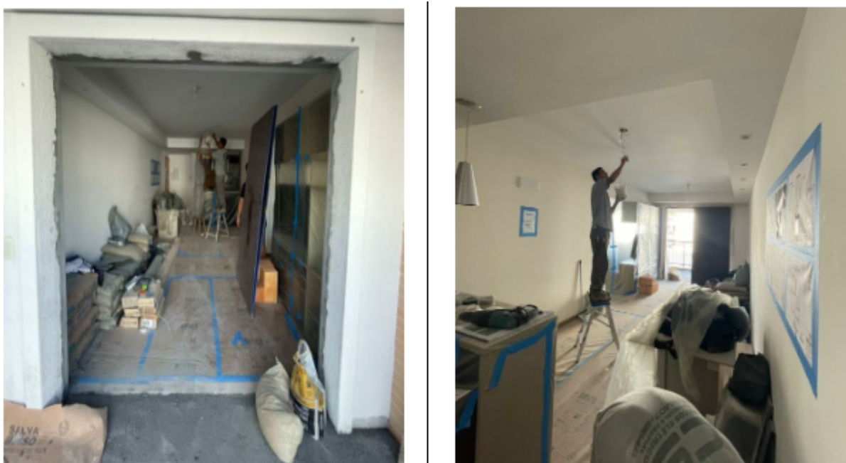
Figura 76 – Atividades na sala, Obra 04
