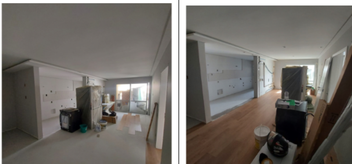
Figura 75 – Instalação de piso vinílico, Obra 03
