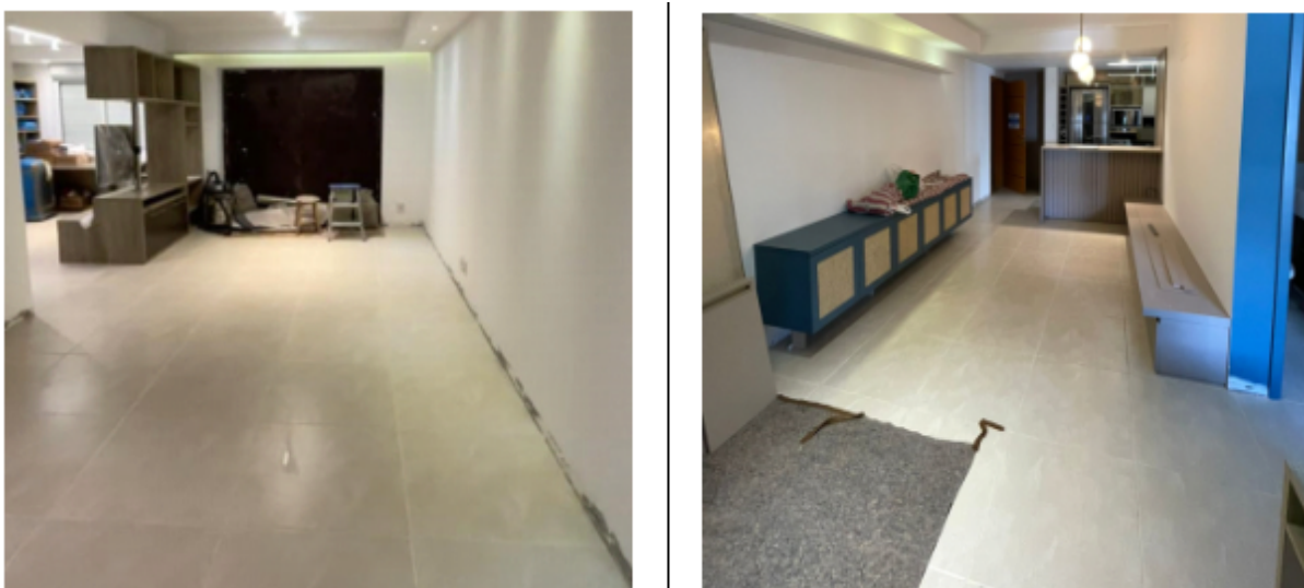
Figura 77 – Finalização da sala, Obra 04
