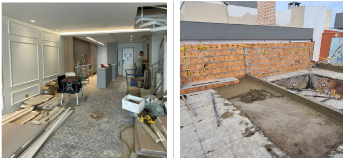
Figura 78 – Sala e área da piscina durante a empreitada, Obra 05
