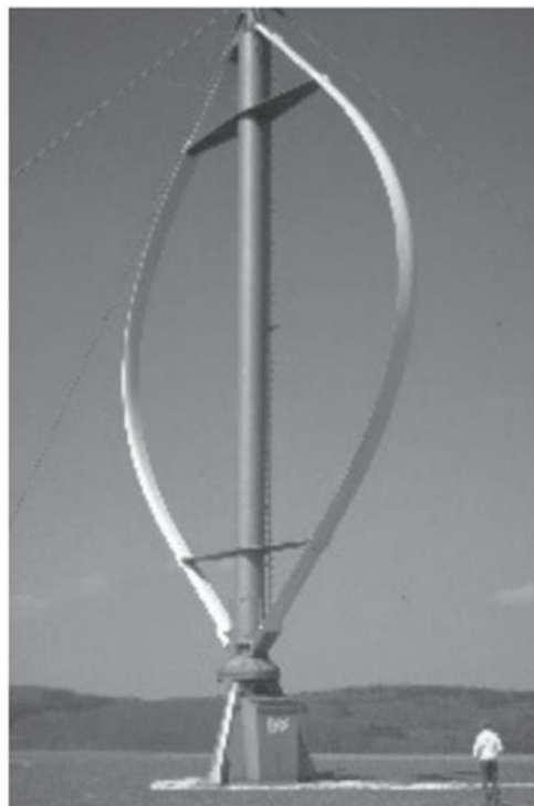
Figura 7 - Turbina de eixo vertical modelo Darrieus.
