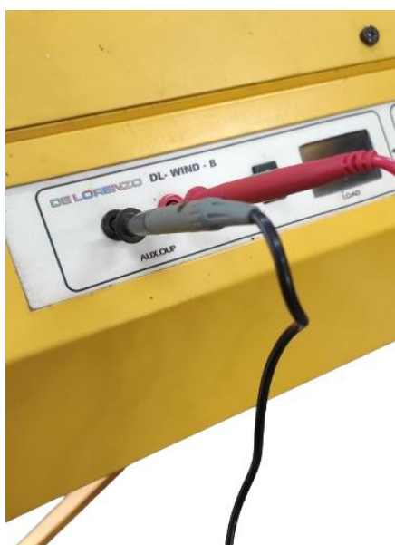
Figura 34 - Medição de tensão através de multímetro.
