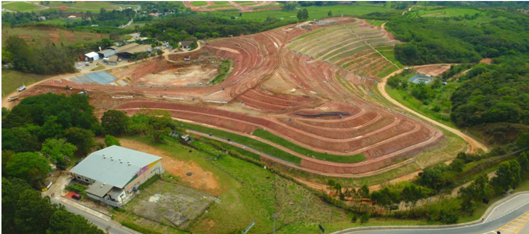
Figura 3 - Talude Artificial: Imagem do Aterro Sanitário Municipal Joseense, São José dos Campos/SP
