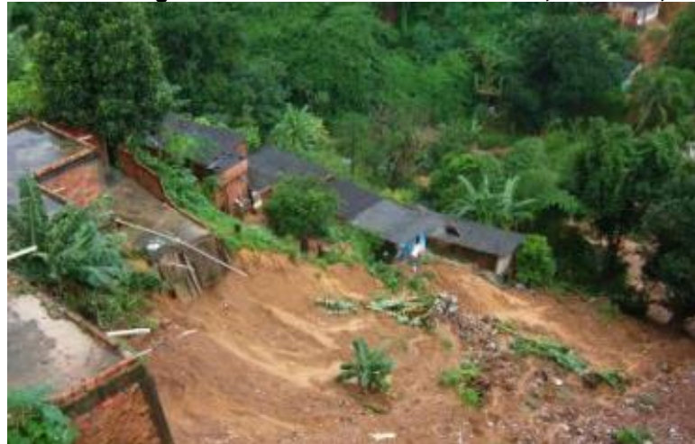
Figura 9 - Escorregamento ocorrido em Vila Canária, Salvador, em 2009
