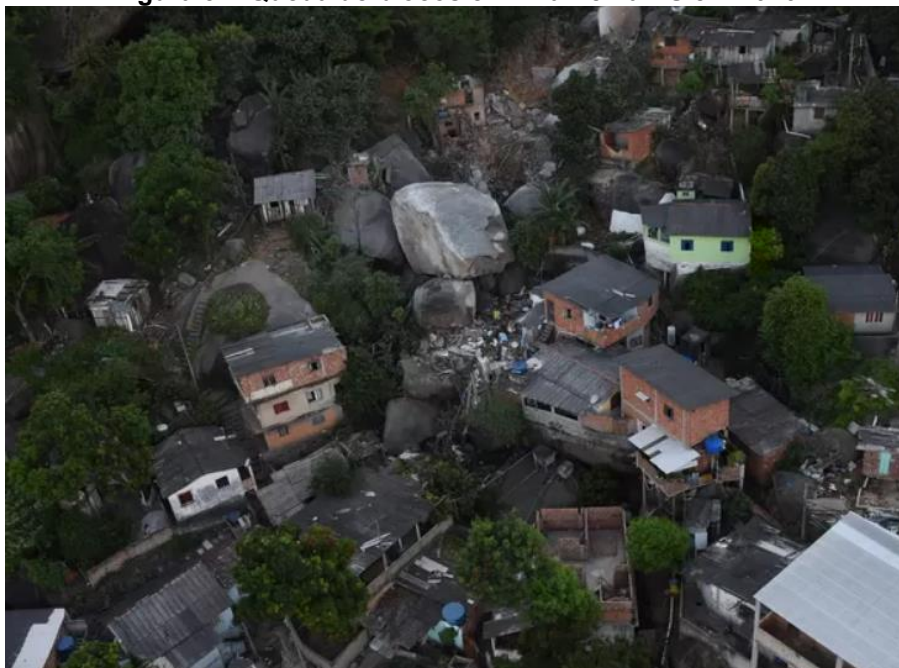
Figura 5 - Queda de blocos em Vila Velha/ES em 2016
