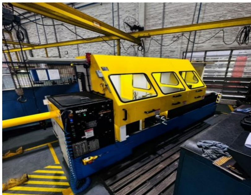
Imagem 2 – Torno com proteções físicas instaladas.
