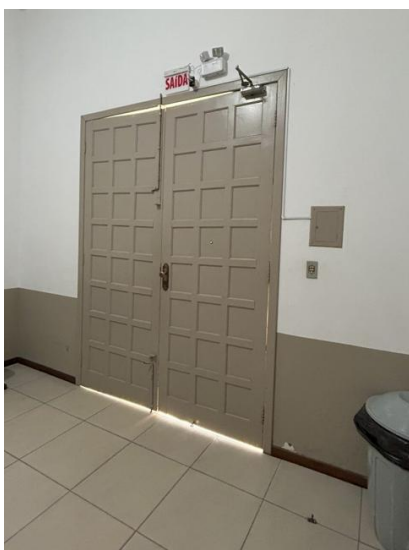
Figura 31 - Porta de acesso ao primeiro pavimento
