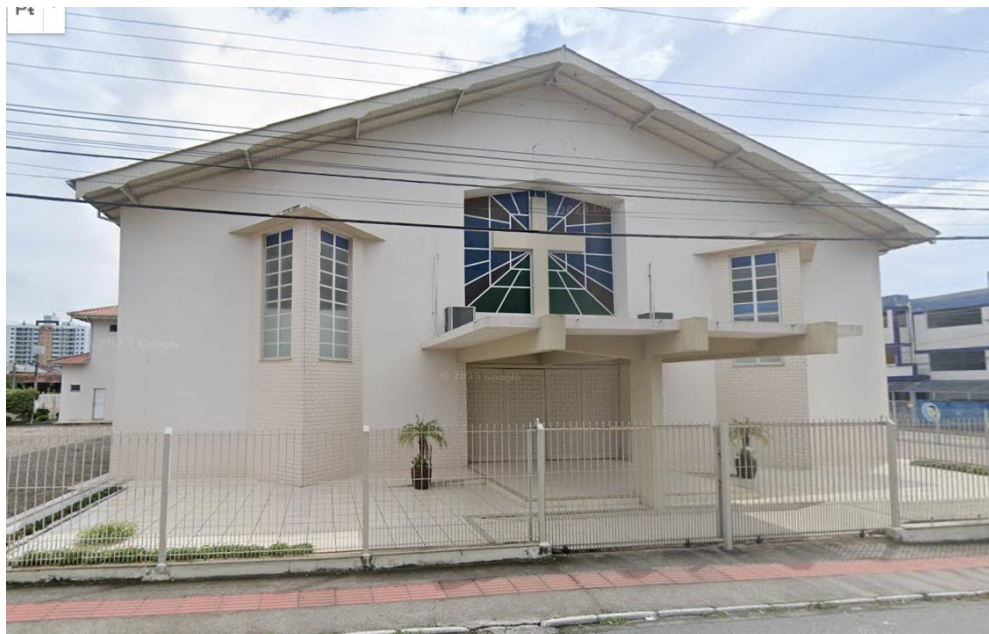
Figura 11 - Fachada da Paróquia da Santa Cruz
