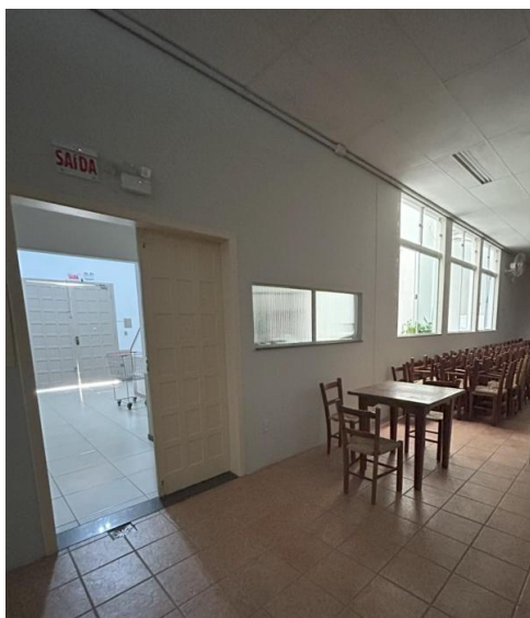
Figura 36 - Porta acesso de serviço do salão de festas
