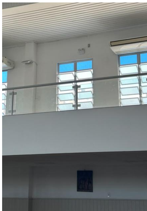
Figura 27 - Luminária no mezanino/nave central
