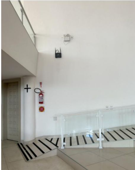
Figura 20 – Extintor altar lado direito
