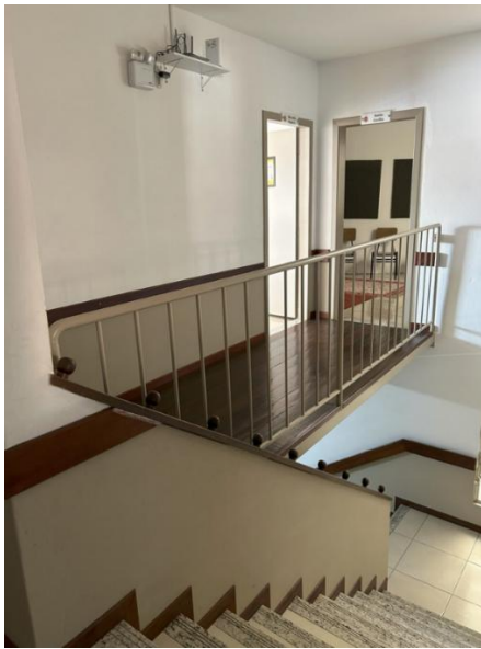
Figura 14 - Salas do lado direito da escada
