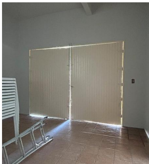
Figura 37 - Porta de acesso principal ao salão de festas
