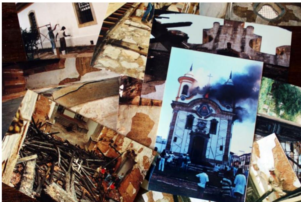
Figura 4 - Fotos do incêndio na Igreja de Nossa Senhora do Carmo
