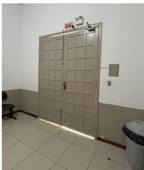
Figura 38 - Porta de acesso ao primeiro pavimento
