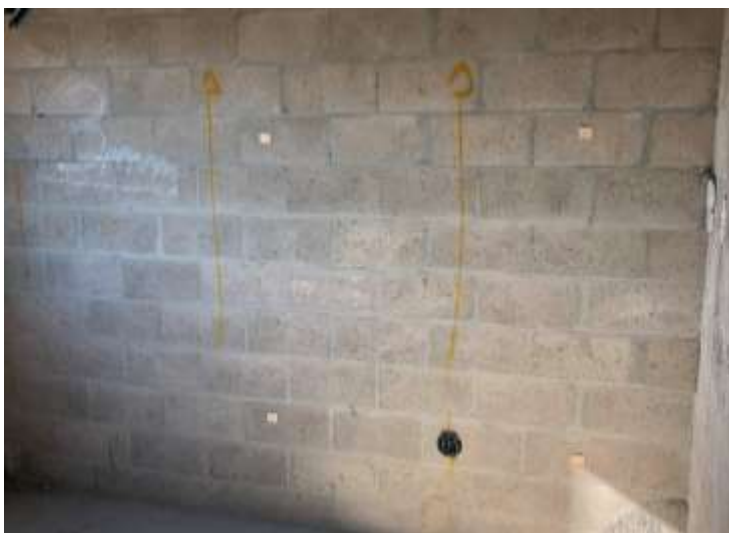
Figura 01: Parede taqueada
