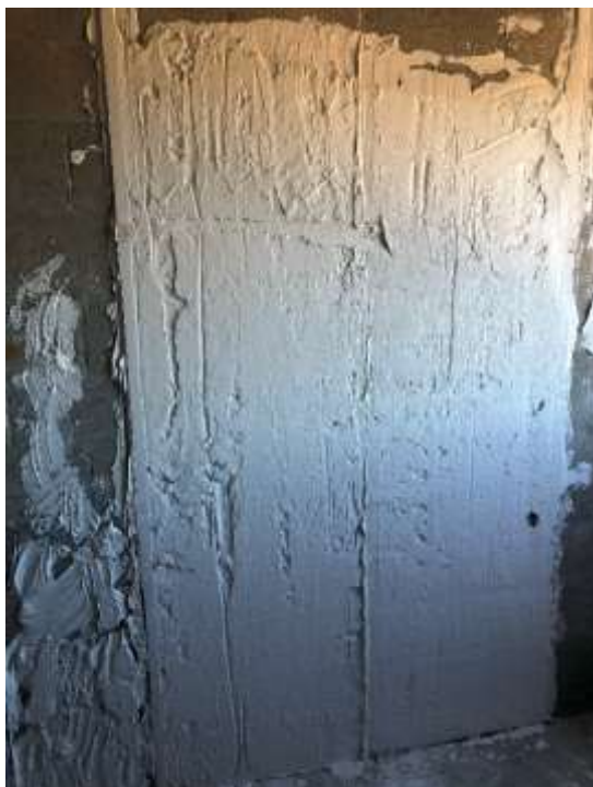
Figura 03: Revestimento de gesso.
