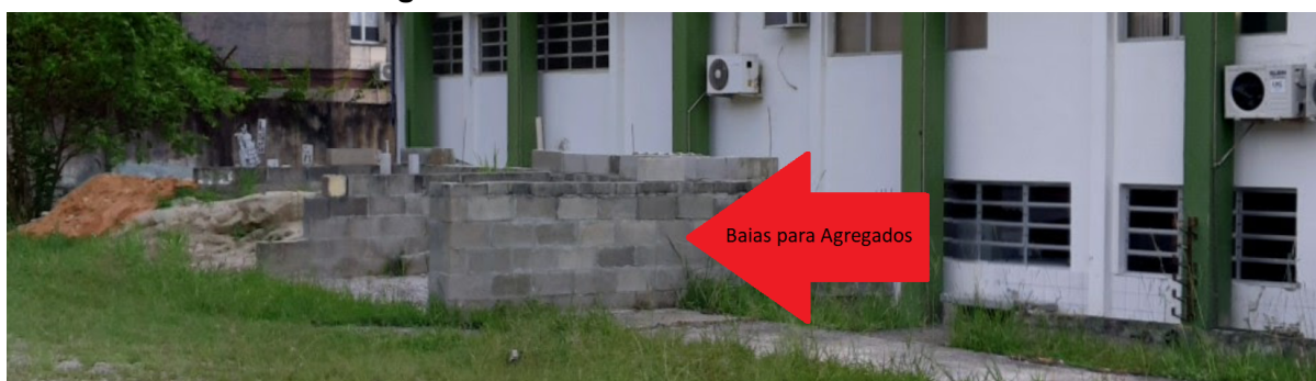
Figura 16: Bacias em bloco de concreto
