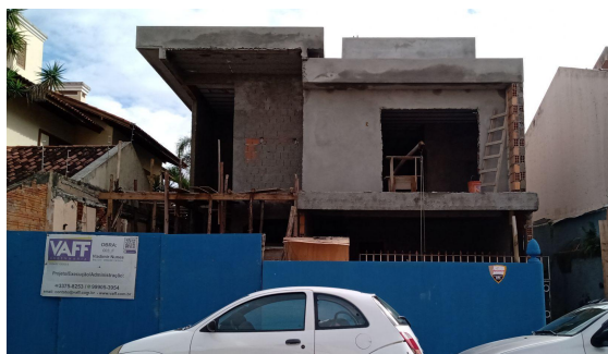
Figura 10 - Fachada frontal da obra
