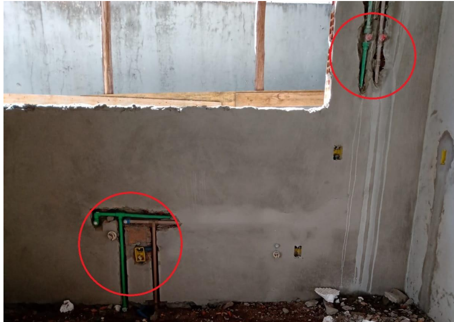
Figura 62 - Correção da descida de água fria
