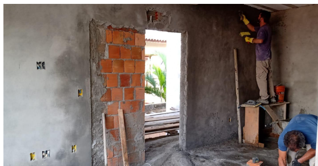
Figura 70 - Correção da passagem da porta de correr na suíte master
