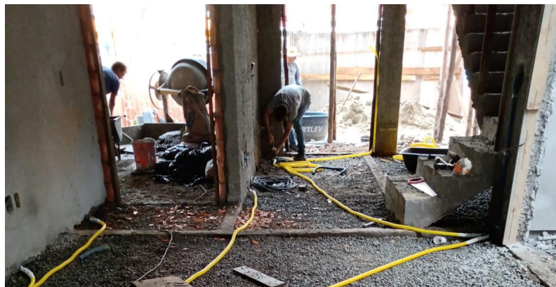
Figura 81 - Execução do interruptor posicionado no pilar
