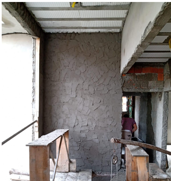
Figura 74 - Passagem de eletrodutos para as luminárias da circulação
