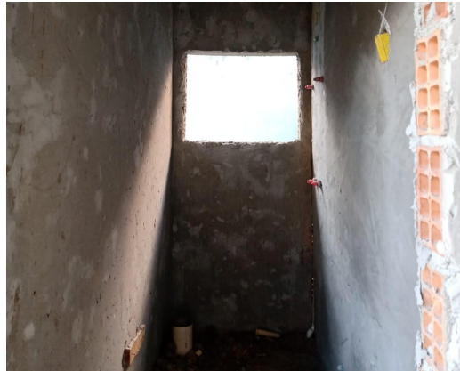
Figura 60 - Vista interna da janela do banheiro da suíte 2 corrigida
