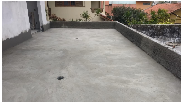
Figura 56 - Sacada traseira dos quartos “as built”
