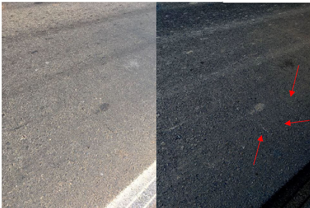
Figura 43 - Trincas interligadas
