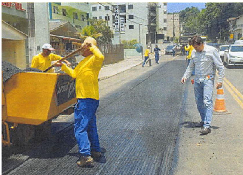
Figura 53 - Pintura de ligação e aplicação de geotelha anti-reflexão
