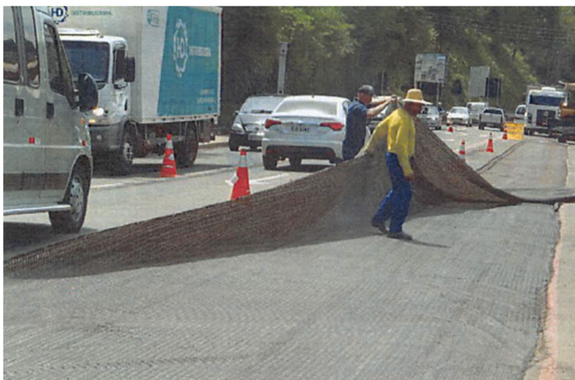
Figura 54 - Aplicação de geogrelha anti-reflexão
