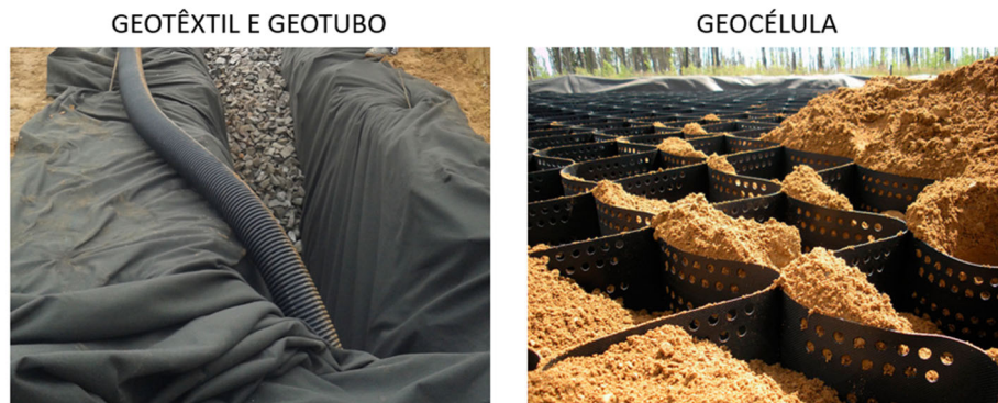
Figura 11 - Aplicação de geotêxtil, geotubo e geocélula
