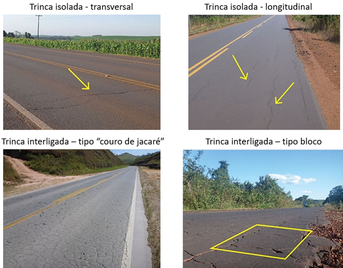
Figura 5 - Tipos de trinca
