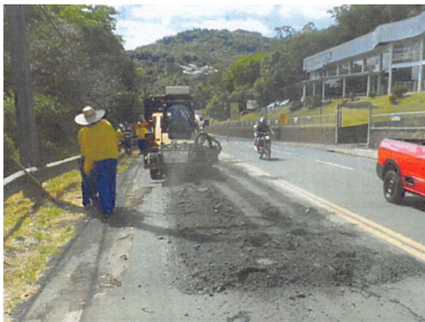
Figura 51 - Fresagem realizada pela empresa 2
