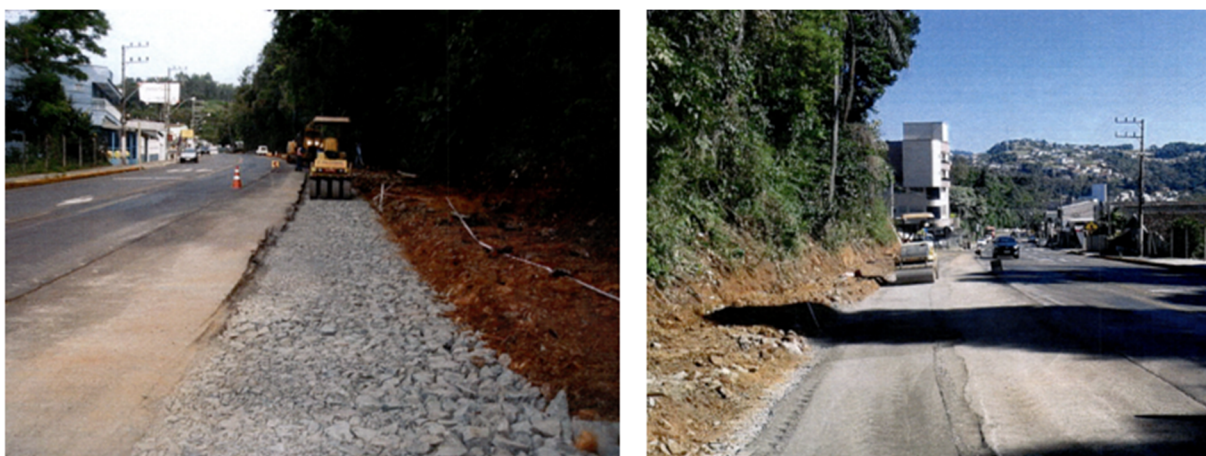
Figura 28 - Execução e compactação de camada de base e sub-base
