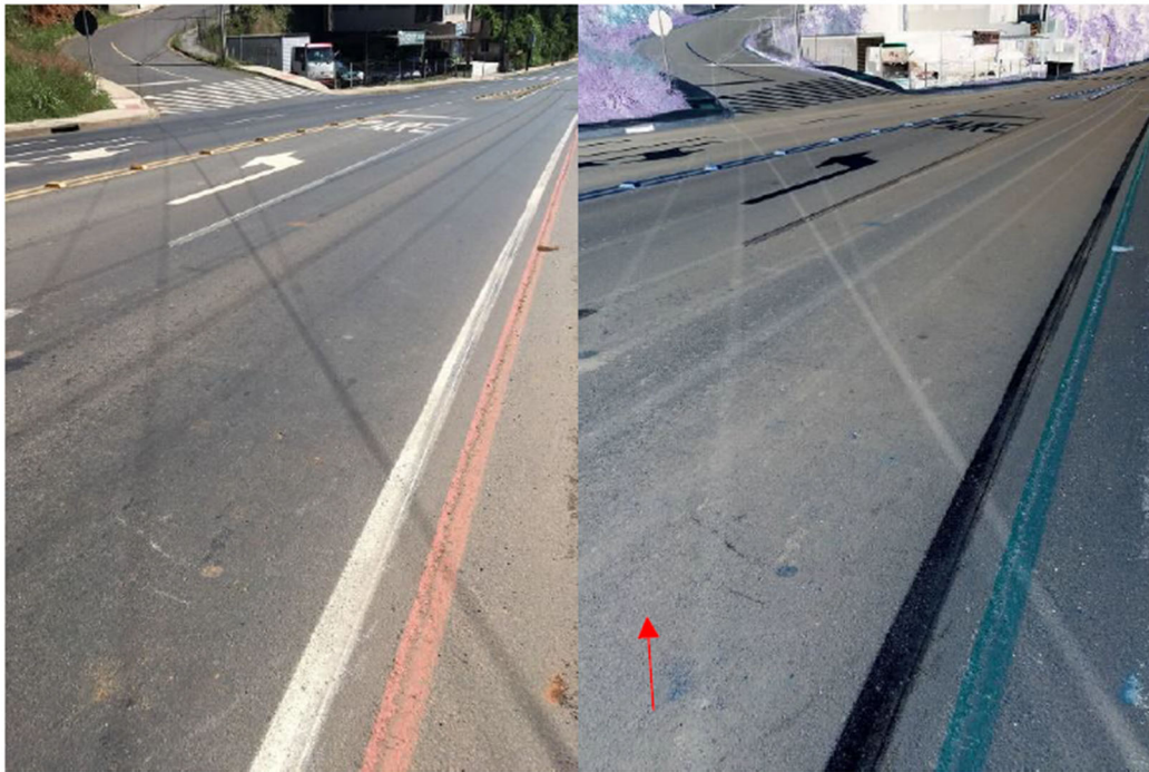
Figura 42 - Trincas isoladas
