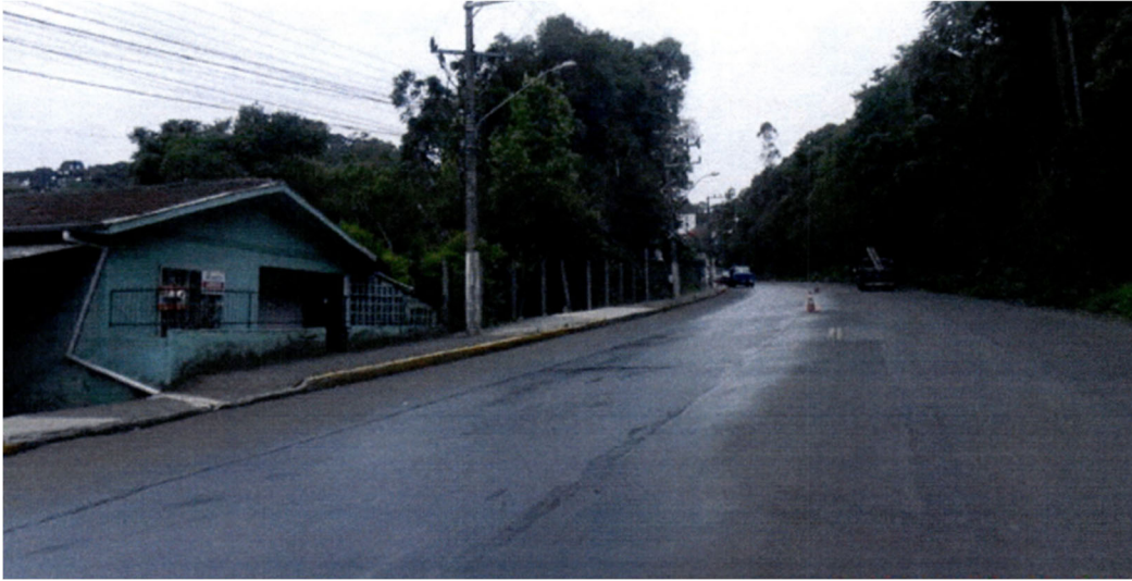
Figura 30 - Execução da pintura de ligação
