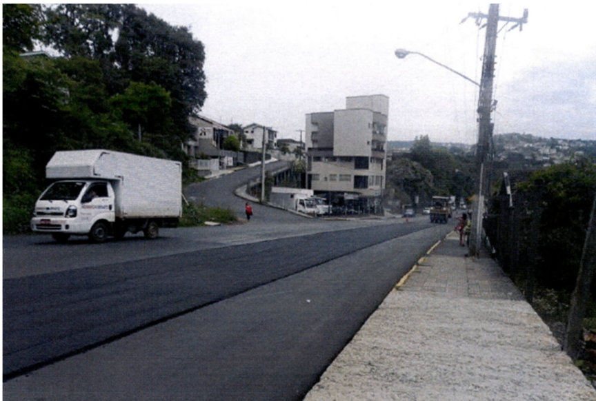
Figura 36 - Execução e compactação da capa asfáltica
