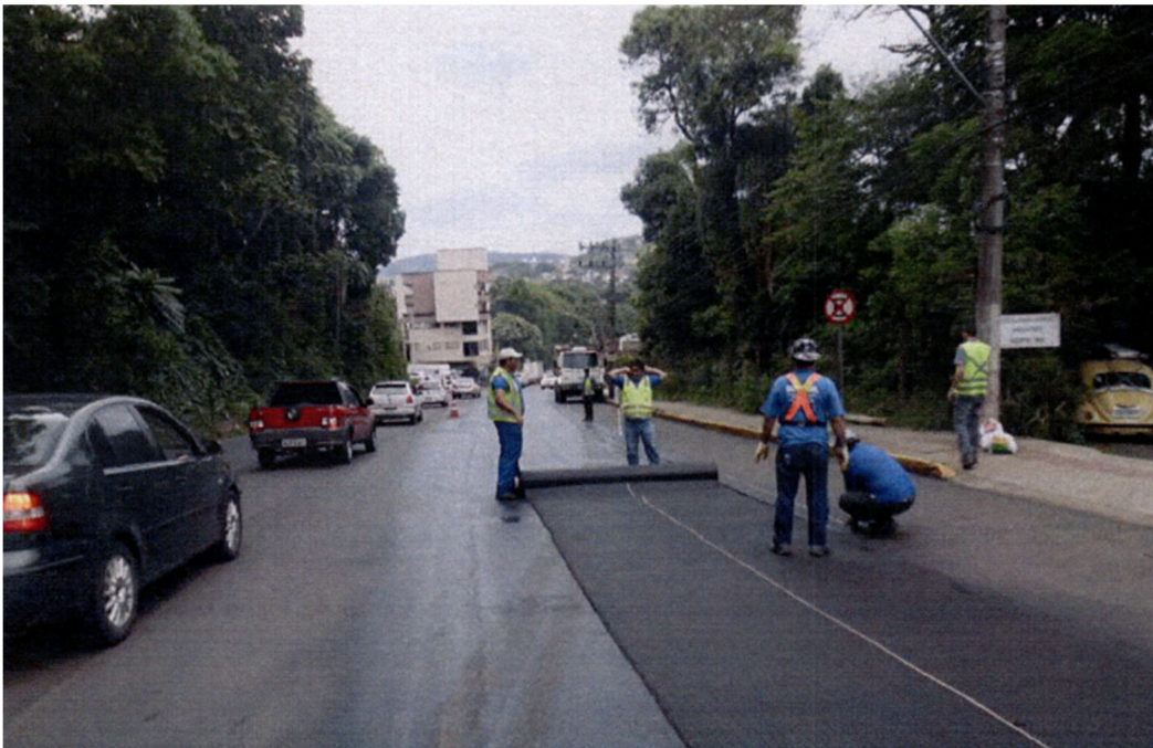
Figura 31 - Aplicação da geogrelha anti-reflexão
