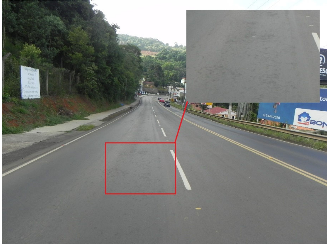
Figura 39 - Desagregação
