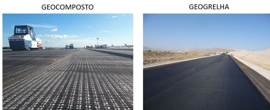
Figura 12 - Aplicação de geocomposto e geogrelha
