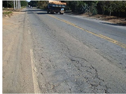
Afundamento de trilha de roda
