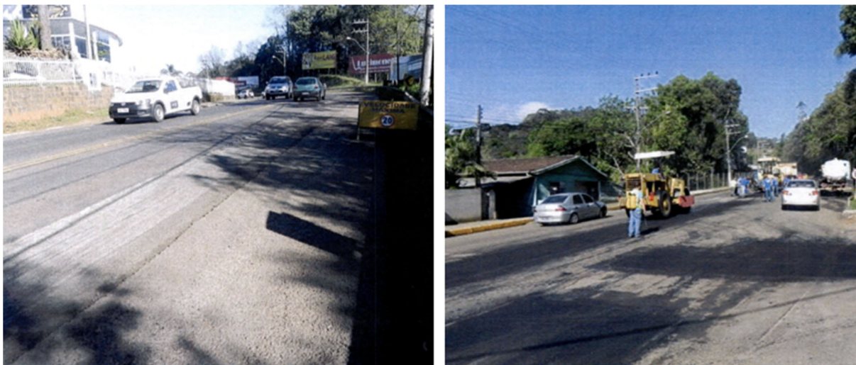
Figura 29 - Fresagem e recomposição dos pontos fresados
