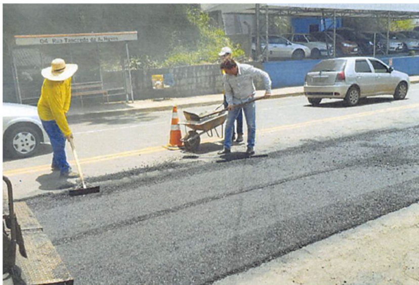
Figura 56 - Recomposição da capa asfáltica e compactação
