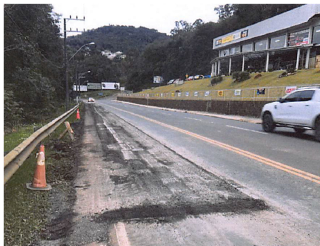
Figura 41 - Fresagem realizada pela empresa 1
