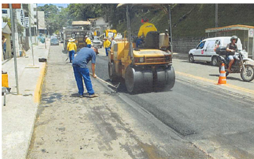
Figura 55 - Recomposição da capa asfáltica e compactação
