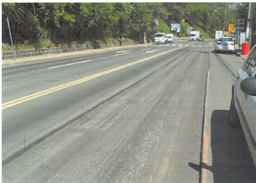
Figura 52 - Fresagem realizada pela empresa 2
