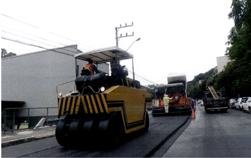
Figura 35 - Execução e compactação da capa asfáltica
