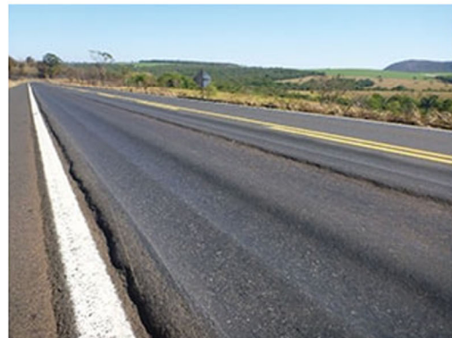
Afundamento de trilha de roda
