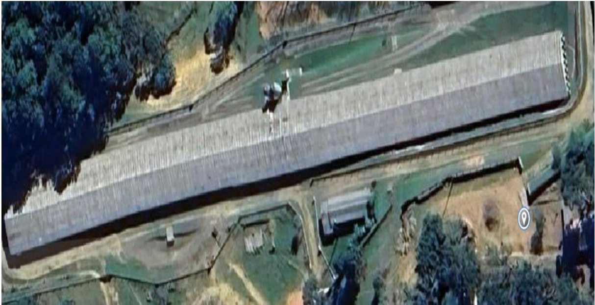
Figura 11 – Aviário que será feita a instalação dos módulos.
