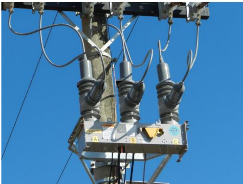
Figura 11 - Religador automático trifásico
