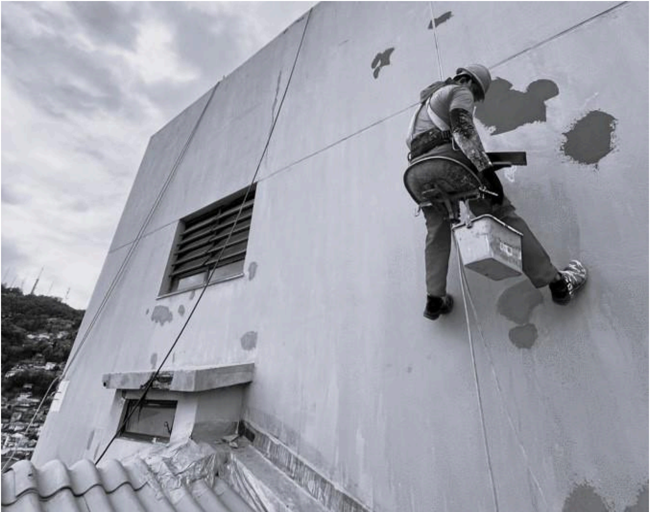
Figura 26 - Execução de reparos na torre da caixa d'água com uso de cadeirinha em condomínio no Centro de Florianópolis/SC
