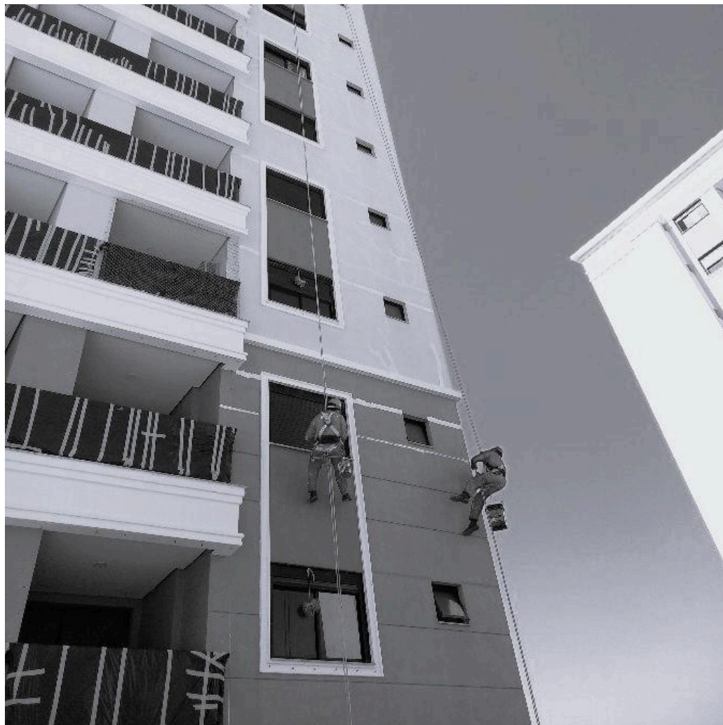
Figura 24 - Trabalhadores da Empreiteira X suspensos por cadeirinha para pintura de edifício no bairro Itacorubi, em Florianópolis/SC
