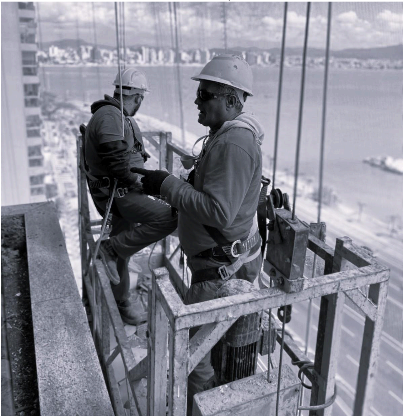
Figura 28 - Trabalhadores em balancim elétrico/jáú para execução de serviço em fachada de edifício no Centro de Florianópolis/SC
