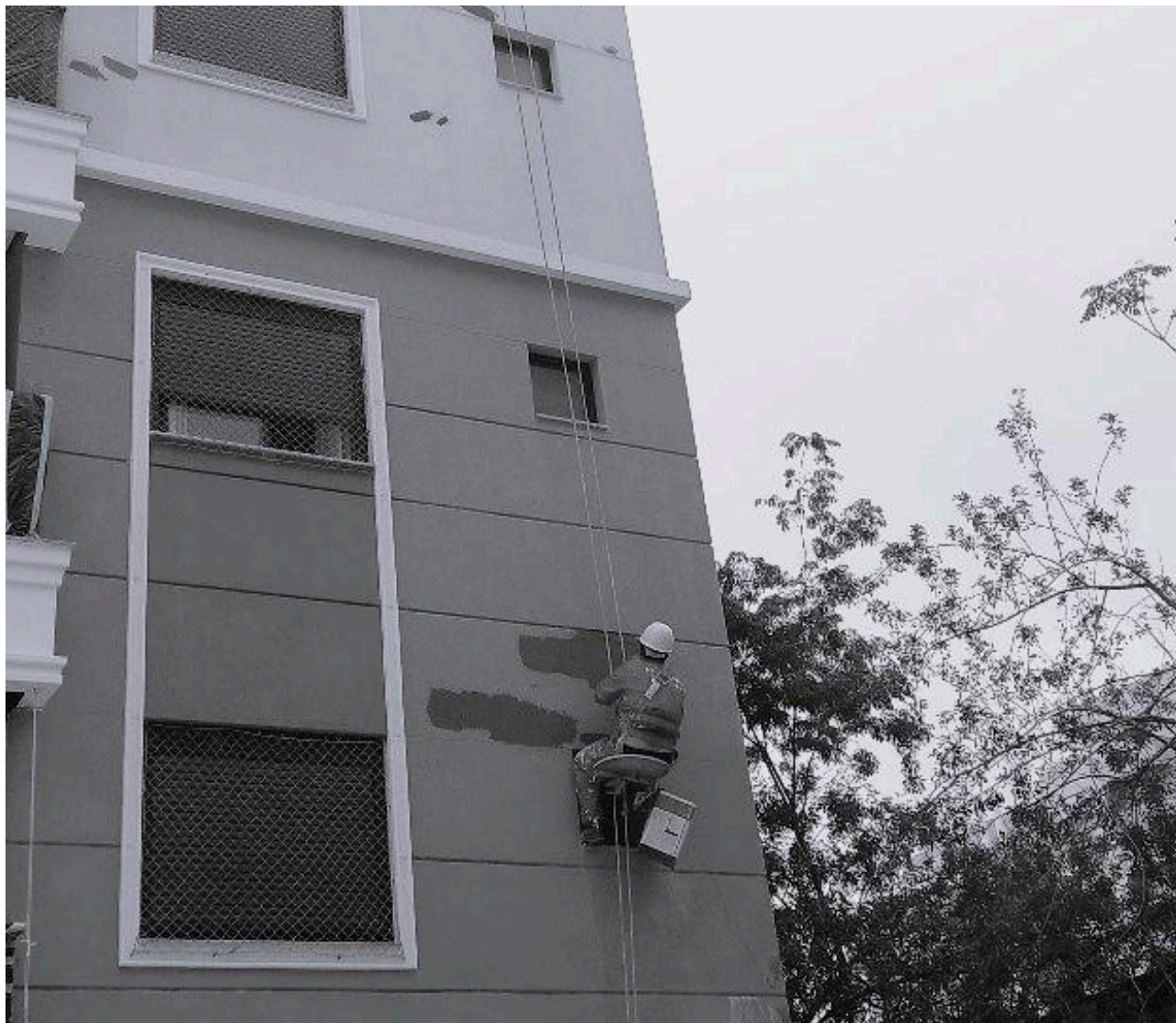
Figura 25 - Trabalhador suspenso por cadeirinha para realização do serviço de recuperação de fissuras na fachada de edifício localizado no bairro Itacorubi, em Florianópolis/SC
