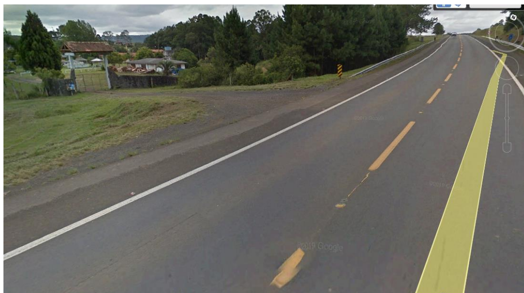
Figura 21 – Acesso residencial (A5-S)
