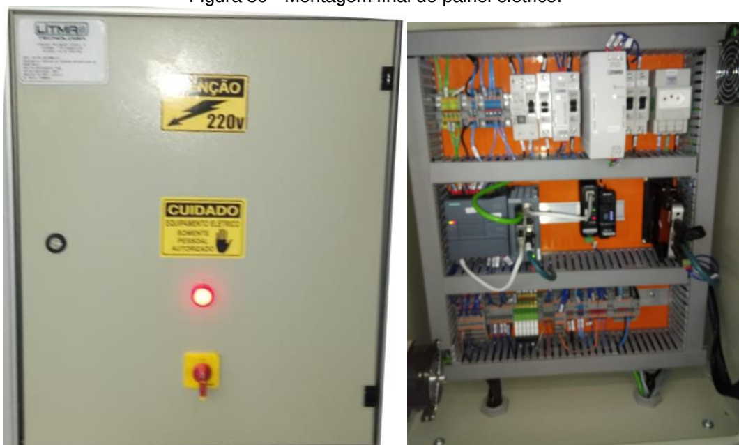
Figura 30 - Montagem final do painel elétrico.
