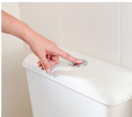
Figura 4 - Bacia sanitária com caixa acoplada e botão enclausurado
