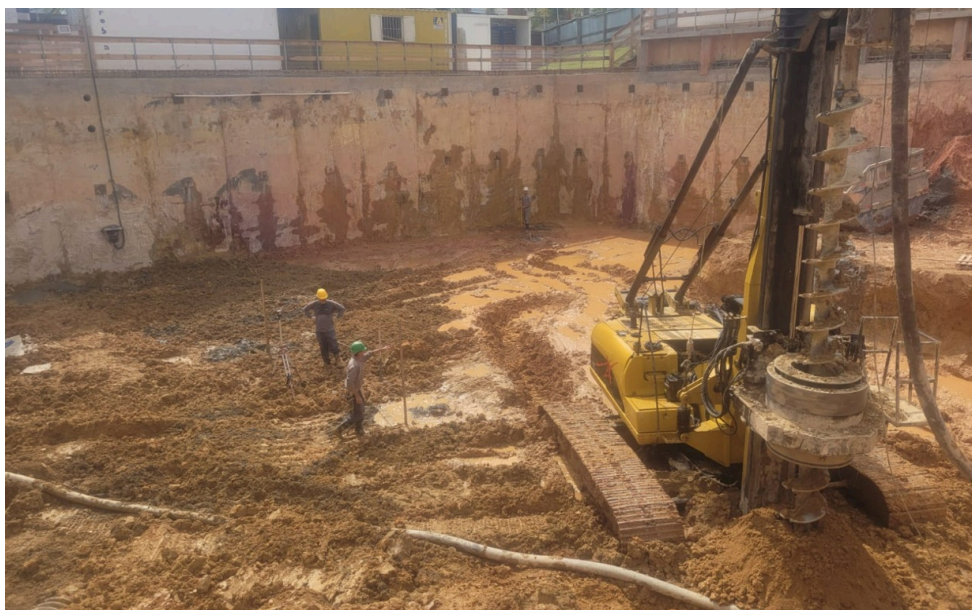
Figura 14 - Execução de estaca hélice contínua
