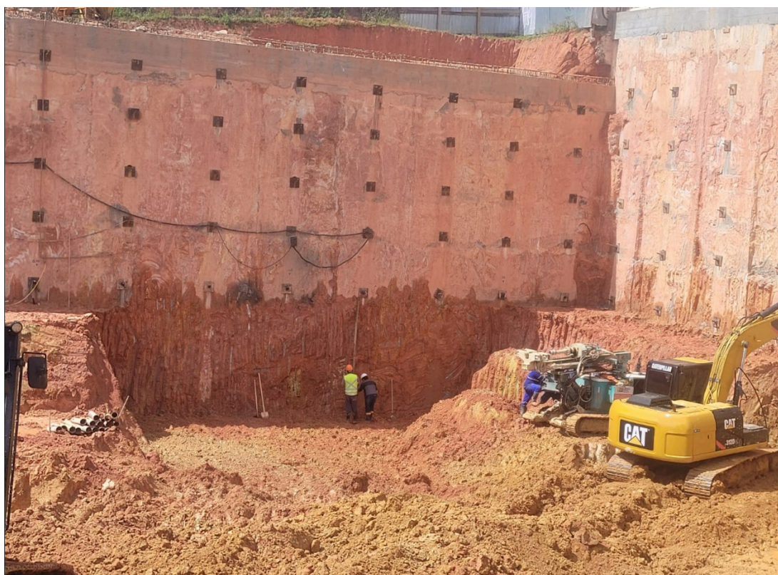
Figura 13 - Parede diafragma com tirantes
