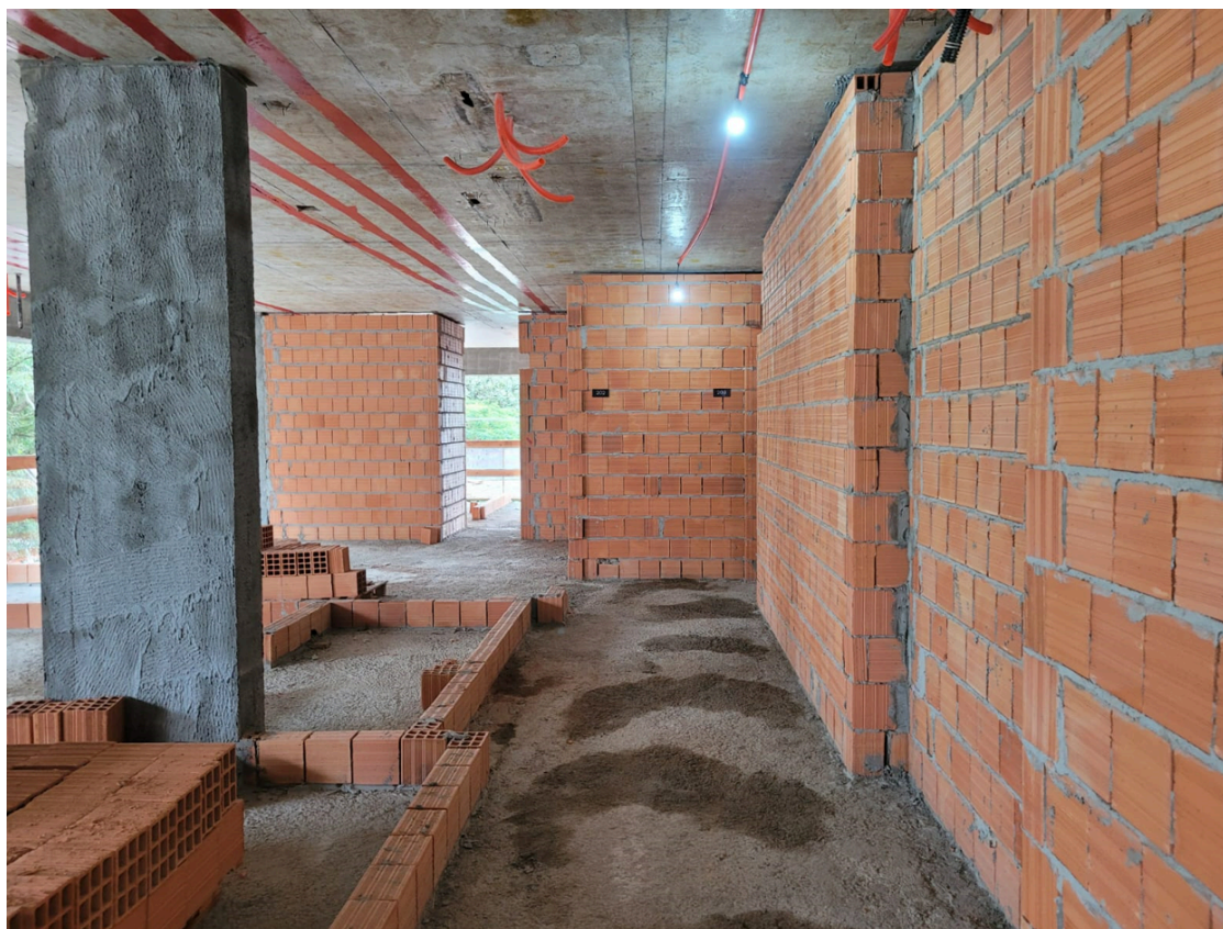
Figura 15 - Demarcação da posição dos cabos protendidos da laje
