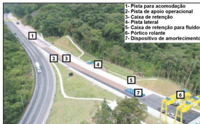
Figura 10 - Área de escape tipo caixa de retenção
