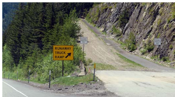
Figura 8 - Rampa de gravidade
