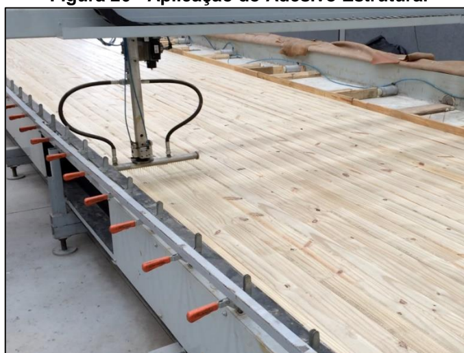
Figura 26 - Aplicação do Adesivo Estrutural
