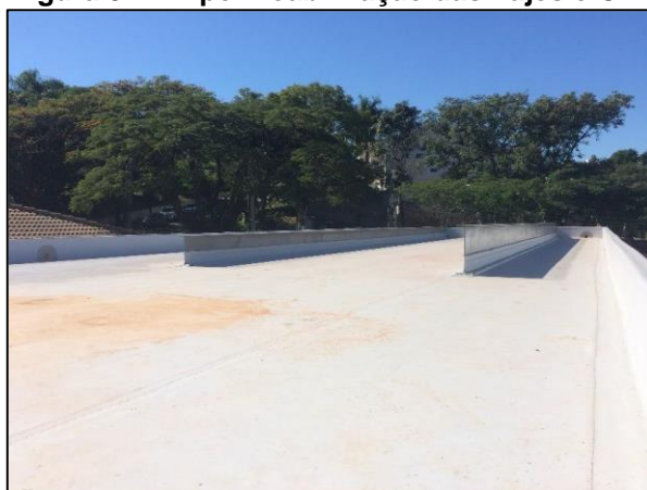
Figura 37 - Impermeabilização das Lajes e CLT
