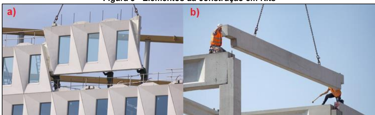
Figura 3 - Elementos da construção em Kits
