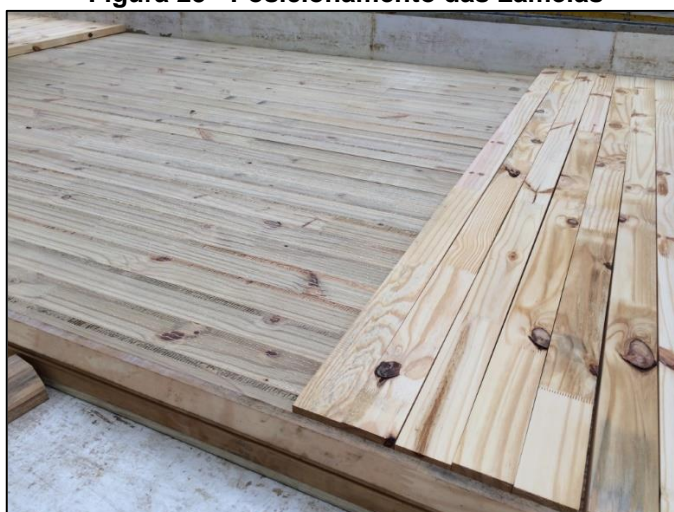
Figura 25 - Posicionamento das Lamelas
