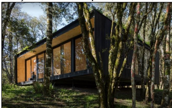
Figura 8 – Construção modular da empresa Crosslam: Minimod Curucaca
