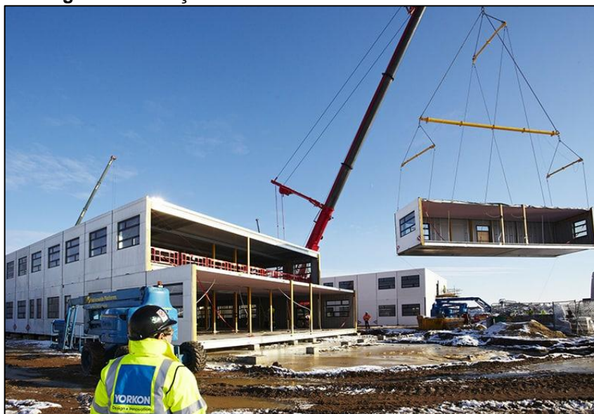
Figura 6 - Locação dos módulos volumétricos no canteiro
