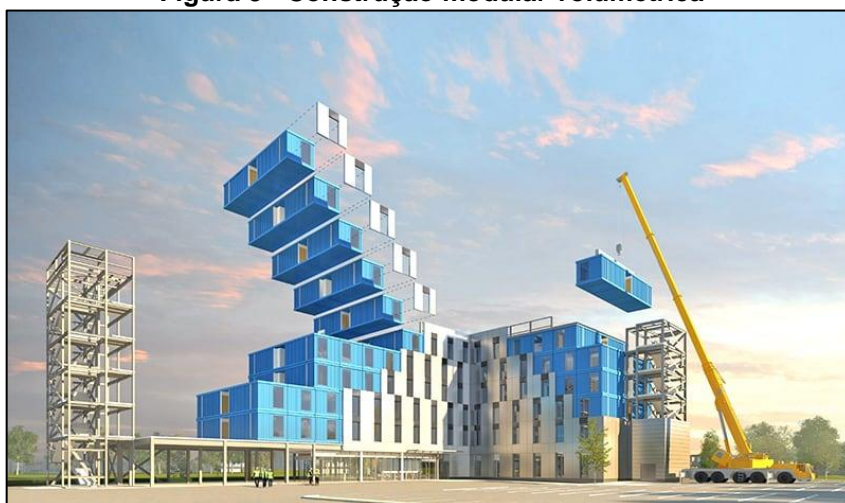
Figura 5 - Construção modular volumétrica
