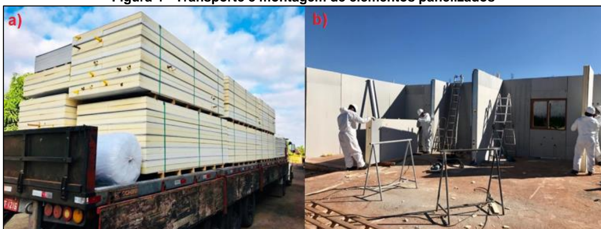
Figura 4 - Transporte e montagem de elementos panelizados
