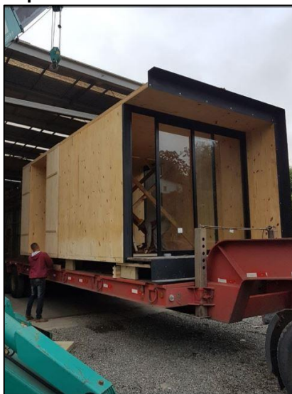
Figura 9 - Transporte de módulo em madeira engenheirada
