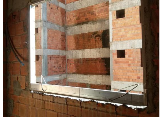
b) Instalação do contramarco
