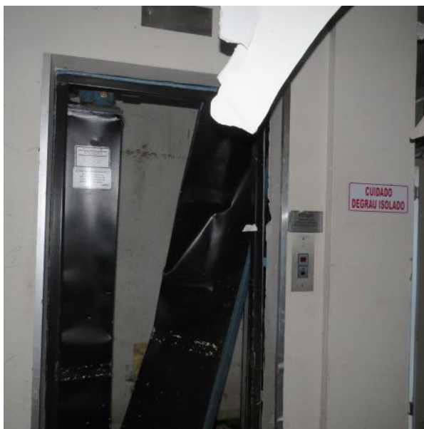
Figura 26 - Porta do elevador subsolo
