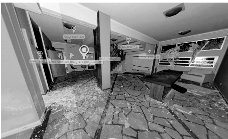
Figura 32 - Quebra de vidros no subsolo após a porta corta-fogo
