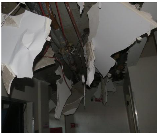
Figura 41 - Tubulação de GLP pelo forro do subsolo
