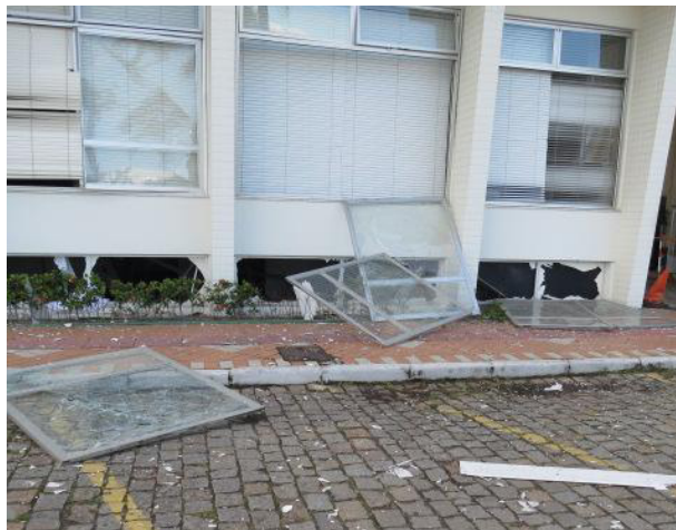
Figura 17 - Vista de parte da fachada frontal
