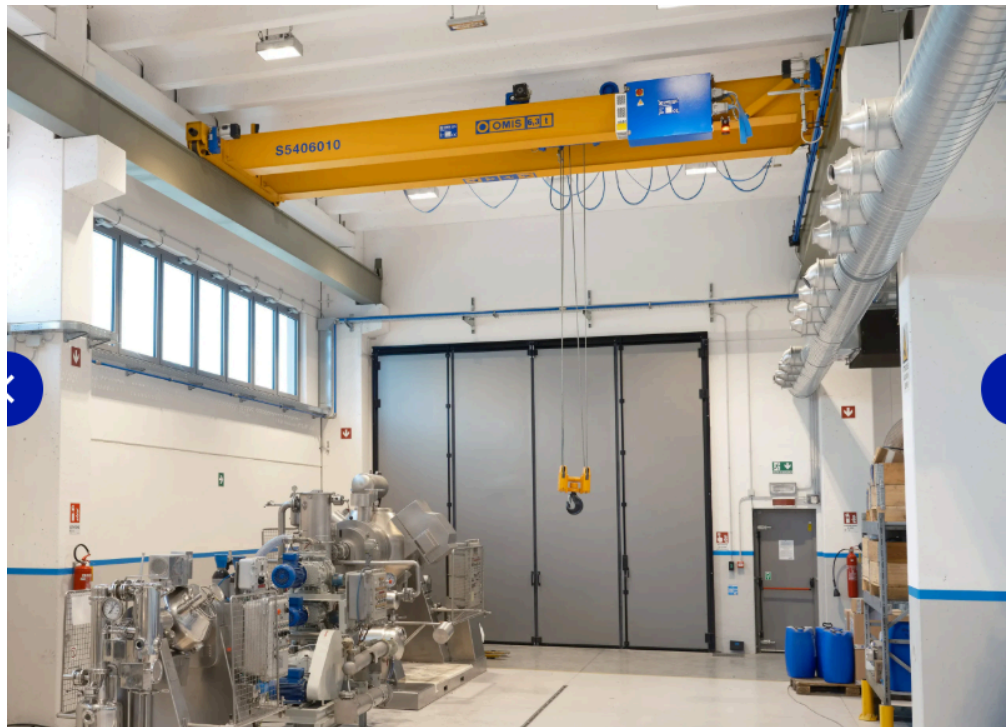
Figura 4 - Ponte Rolante Biviga
