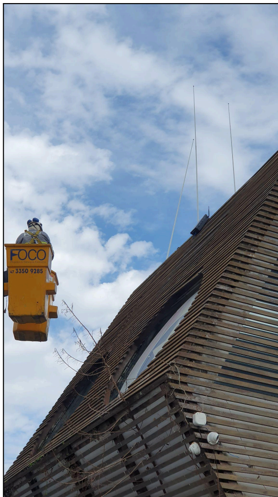
Imagem 35 – Trabalho de instalação do Gateway no telhado finalizado
