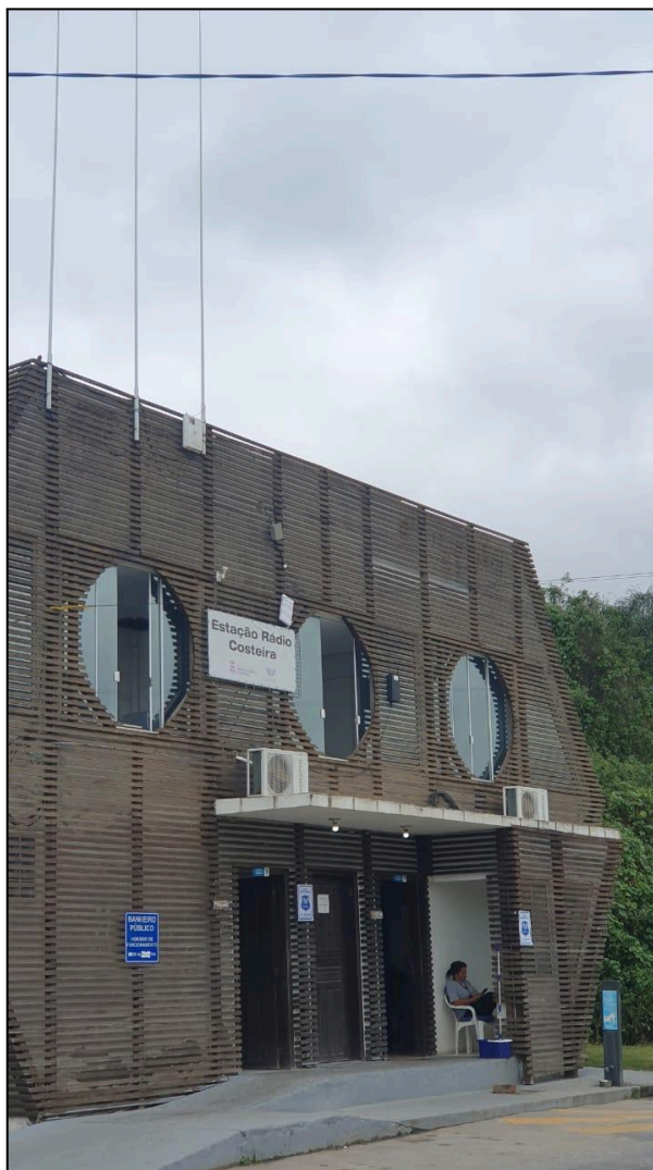
Imagem 24 – Local de instalação provisória do gateway, próximo a janela
