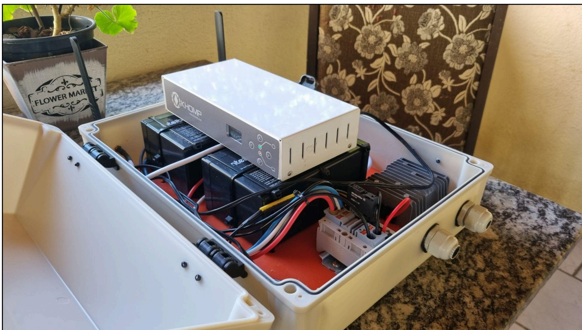
Imagem 51 – Montagem do painel com baterias, gateway, conversor e antenas
