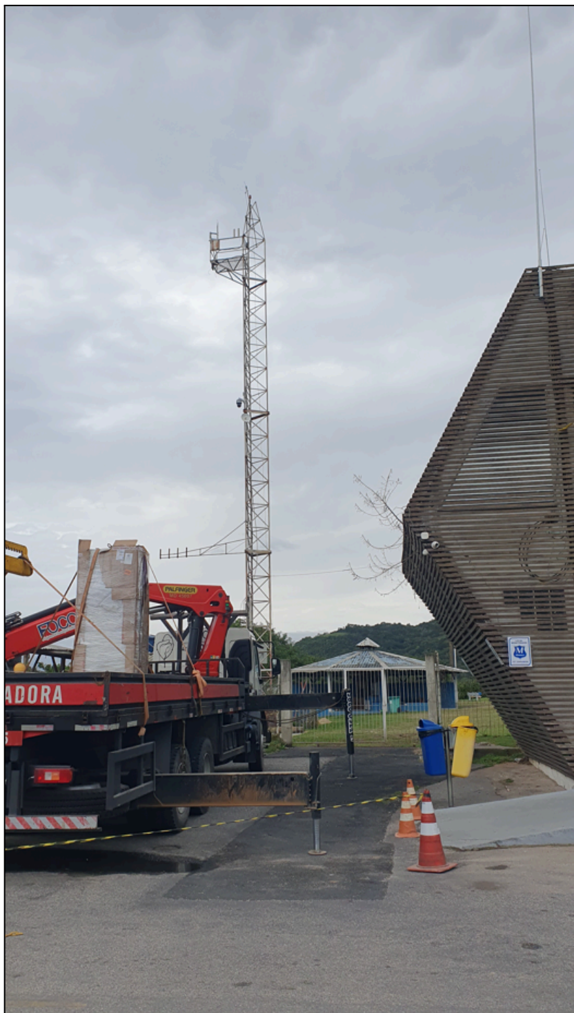
Imagem 34 – Caminhão munck posicionado para iniciar o trabalho de instalação do gateway no telhado
