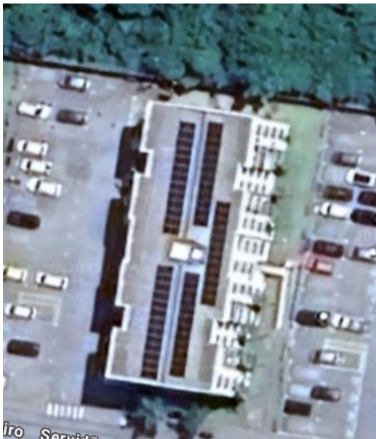
Figura 17 – Vista aérea da CER a ser estudada.
