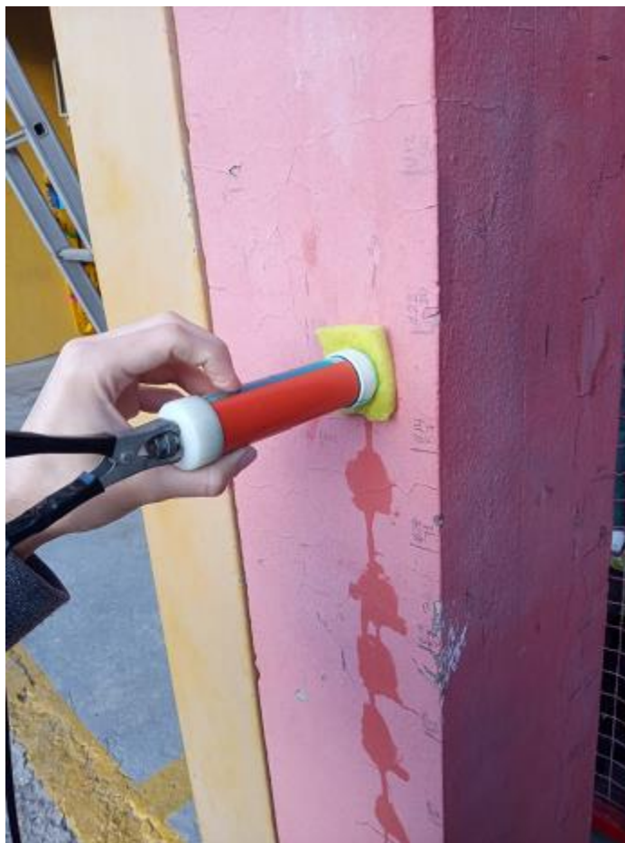
Figura 78 – Eletrodo na face frontal do pilar
