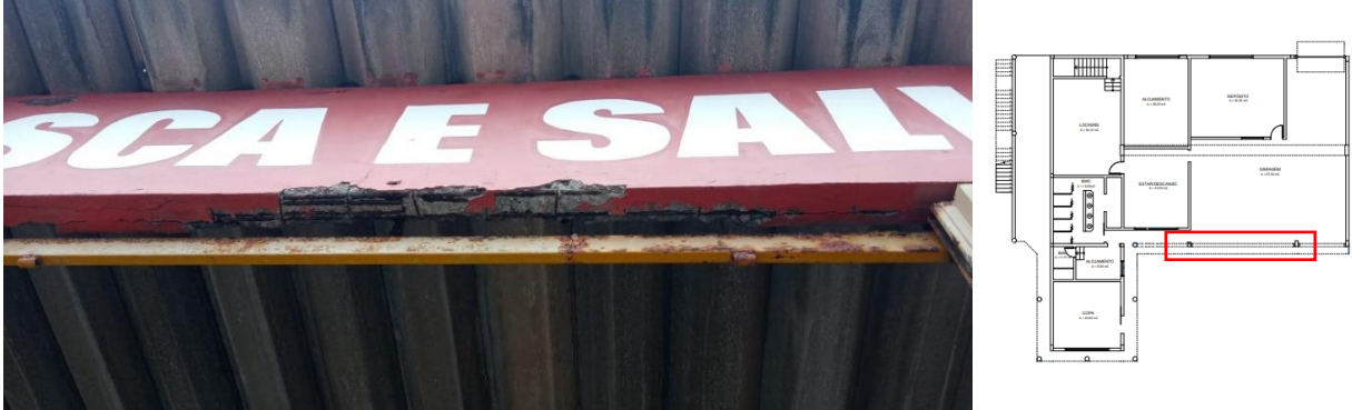
Figura 24 – Viga da fachada noroeste (frontal) da edificação
