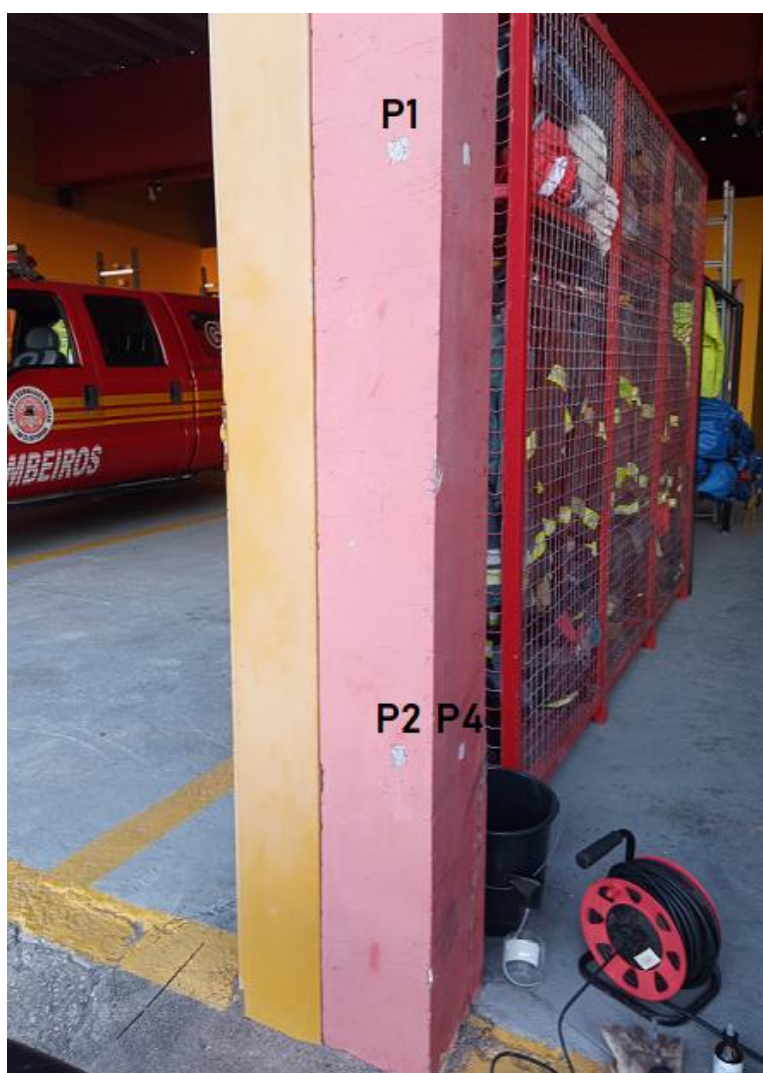
Figura 53 – Pontos escolhidos para coleta das amostras no pilar
