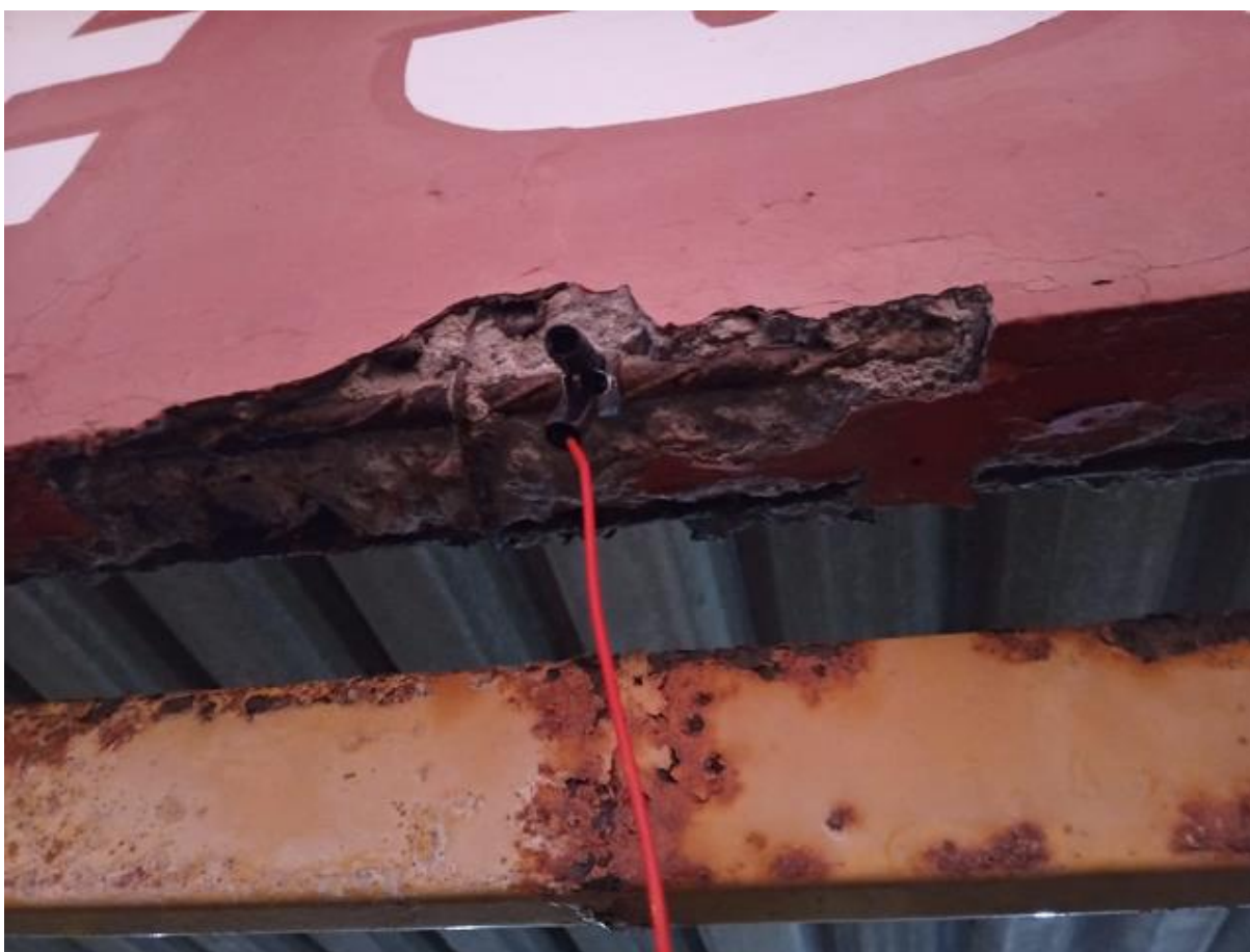
Figura 76 – Conexão do polo positivo com a barra exposta
