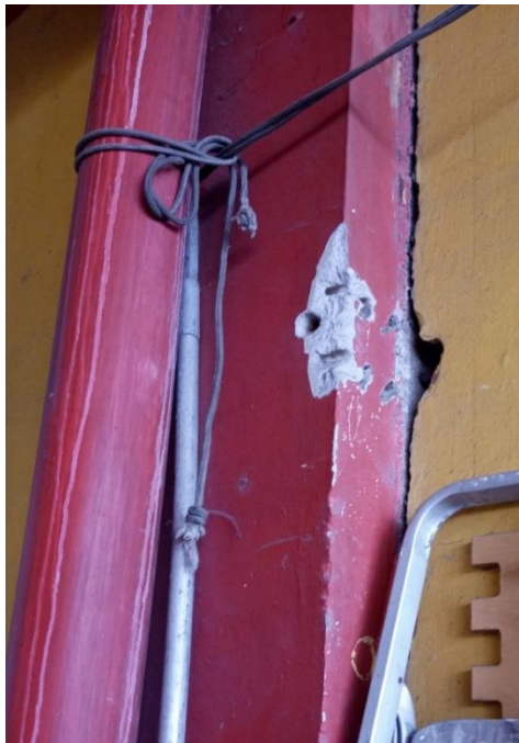
Figura 31 – Pilar e paredes da lateral oeste da edificação
