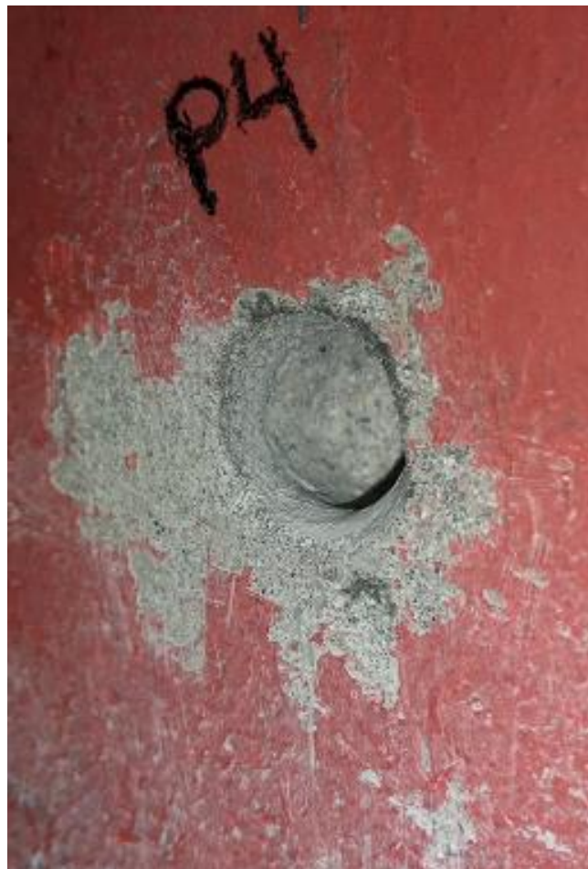
Figura 54 – Perfuração executada no ponto 4 do pilar
