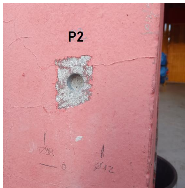
Figura 58 – Perfuração realizada no ponto 2 para coleta
