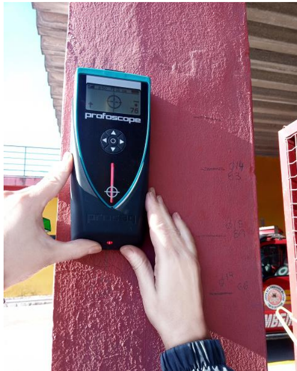
Figura 49 – Utilização do pacômetro para marcação do posicionamento das armaduras dos elementos estruturais analisados
