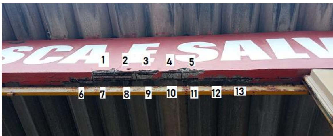
Figura 80 – Regiões medidas, em mm, com o paquímetro
