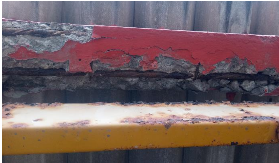
Figura 47 – Região da barra exposta após feita a lixagem pontual
