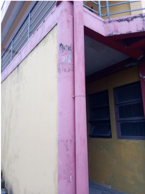
Figura 40 – Parte da lateral oeste da edificação
