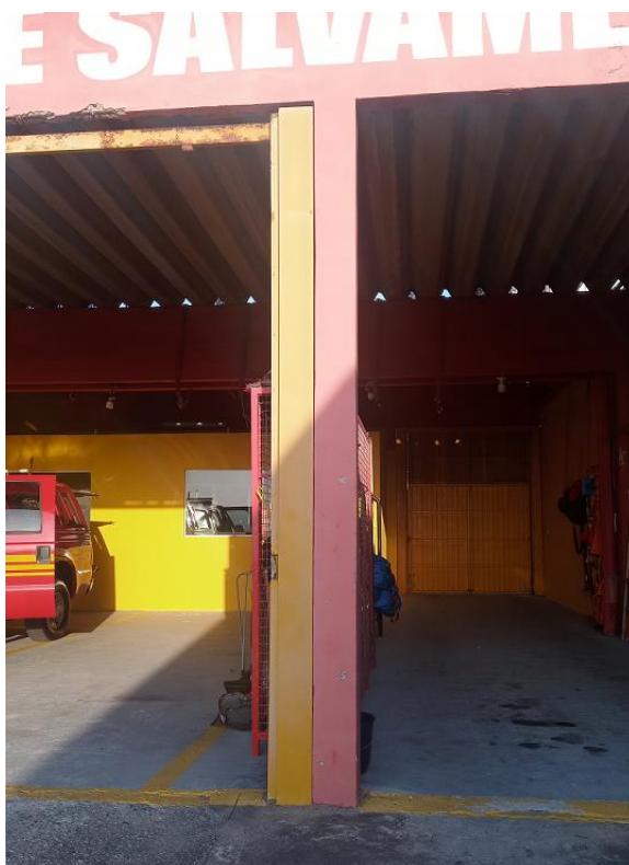
Figura 44 – Elemento estrutural 2: Pilar da fachada noroeste (frontal) da edificação
