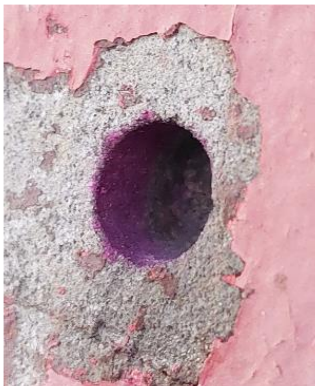
Figura 81 – Perfuração P1 após a ação do reagente fenolftaleína
