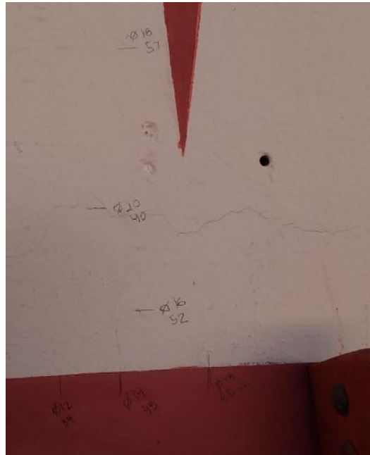
Figura 51 – Marcação da posição, profundidade e bitolas dos vergalhões e estribos da viga
