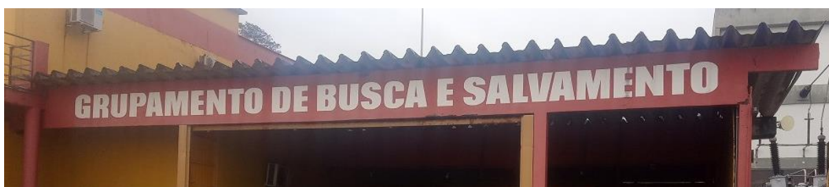
Figura 43 – Elemento estrutural 1: Viga da fachada noroeste (frontal) da edificação
