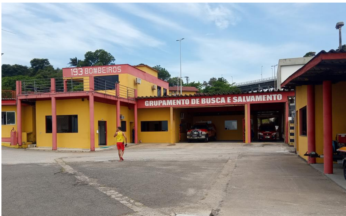
Figura 23 – Fachada da edificação principal do GBS
