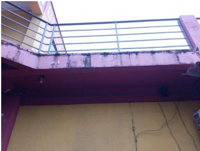
Figura 39 – Laje da lateral oeste da edificação
