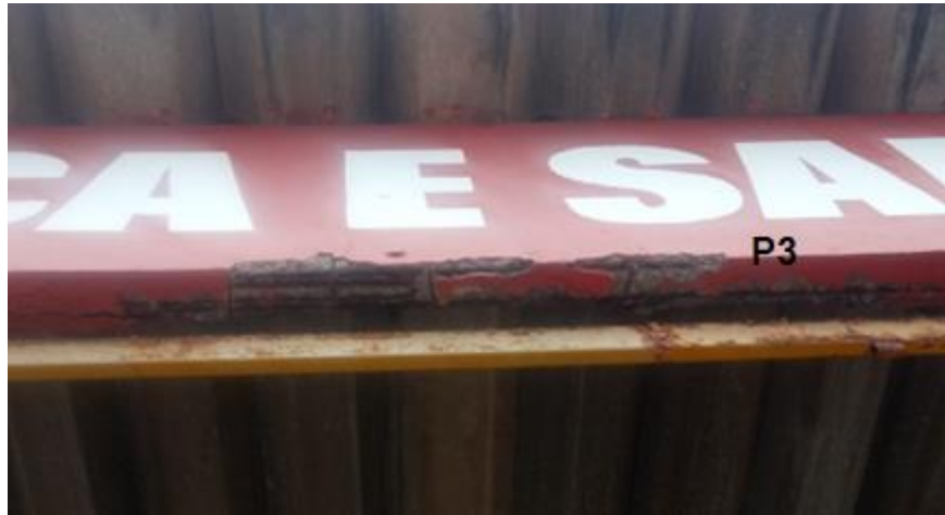
Figura 57 – Ponto escolhido para coleta da amostra na viga
