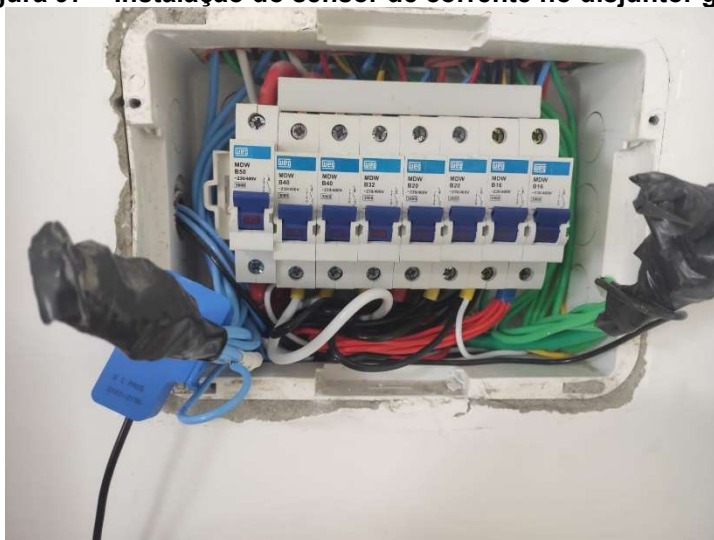
Figura 97 – Instalação do sensor de corrente no disjuntor geral
