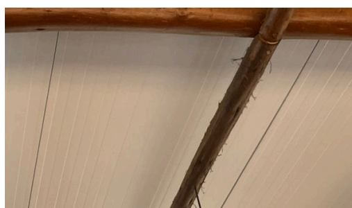
Figura 10 – Tipo de material utilizado no forro da edificação
