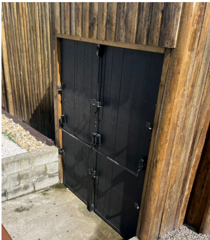
Figura 9 – Uma das Saídas de emergências dispostas na edificação
