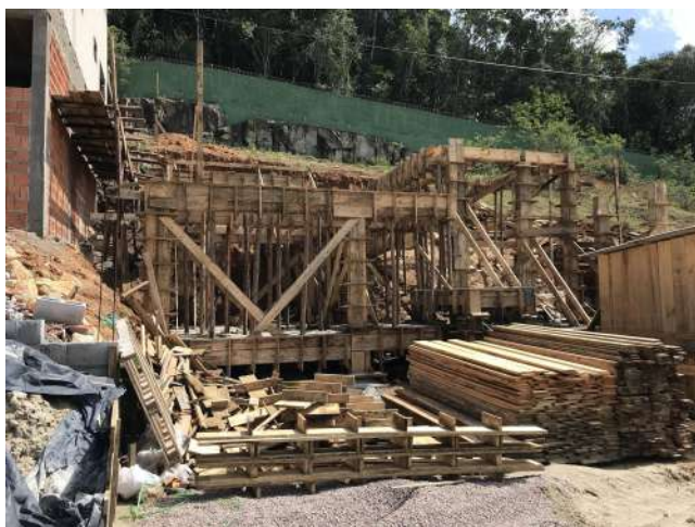
Imagem 10: Estrutura pavimento intermediário 1
