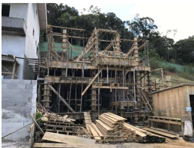
Imagem 13: Estrutura pavimento cobertura
