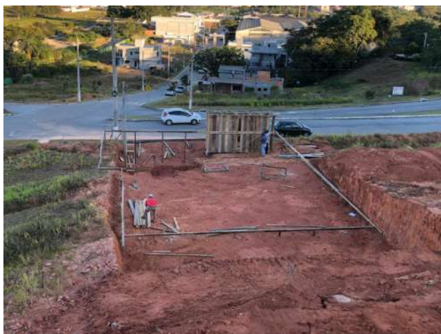
Imagem 21: Terraplanagem/Instalações provisórias
