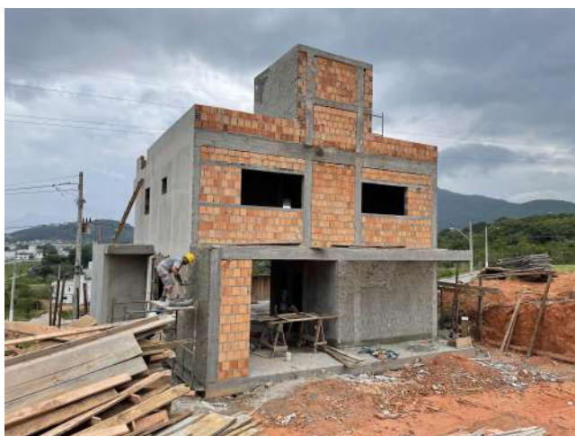
Imagem 28: Reboco/instalação contramarcos
