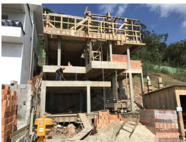
Imagem 17: Início da alvenaria
