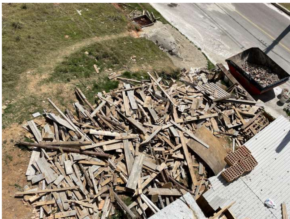
Imagem 32: Pilha de madeira no terreno vizinho
