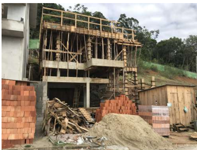
Imagem 16: Estrutura do pavimento cobertura
