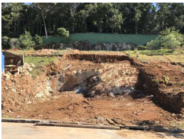
Imagem 07: Terreno após desmonte de rocha
