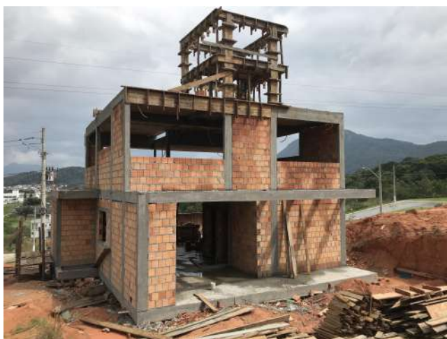
Imagem 25: Estrutura reservatório/alvenaria
