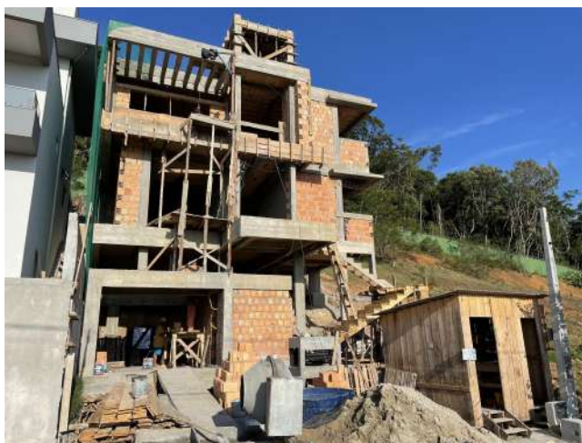
Imagem 18: Etapa de Alvenaria
