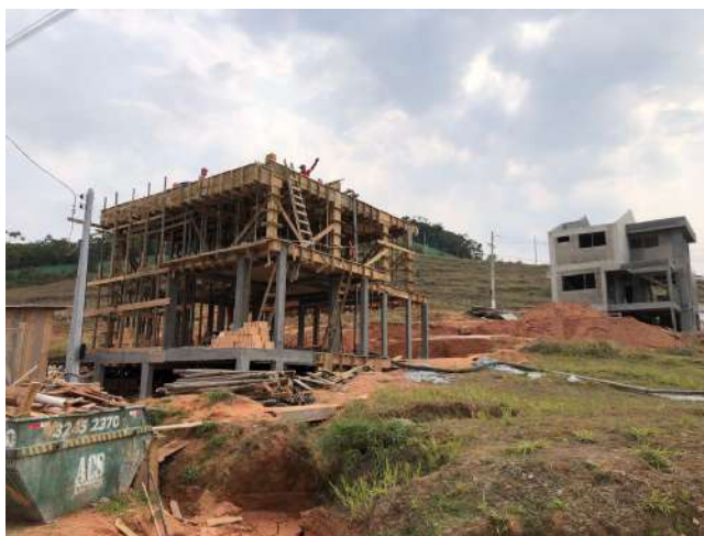
Imagem 24: Estrutura pavimento 2/cobertura
