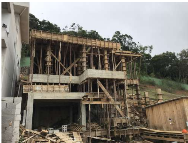
Imagem 15: Estrutura da laje de cobertura
