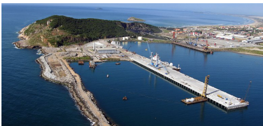
Figura 23 – Porto de Imbituba, Imbituba/SC.
