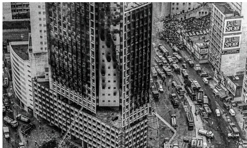
Figura 1 - Incêndio Edifício Joelma
