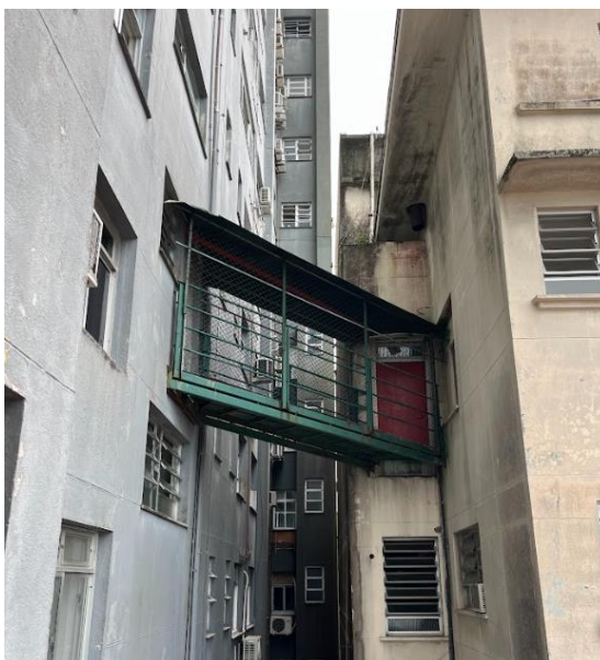
Figura 13 - Passarela de emergência entre edifícios
