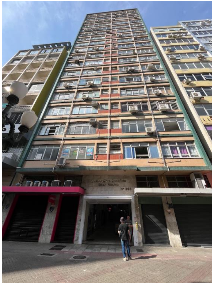
Figura 2 - Fachada edifício Dias Velho
