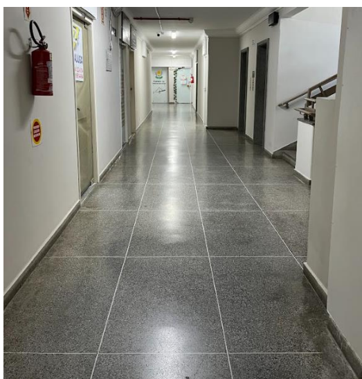
Figura 22 - Hall 8º pavimento (Via de evacuação)
