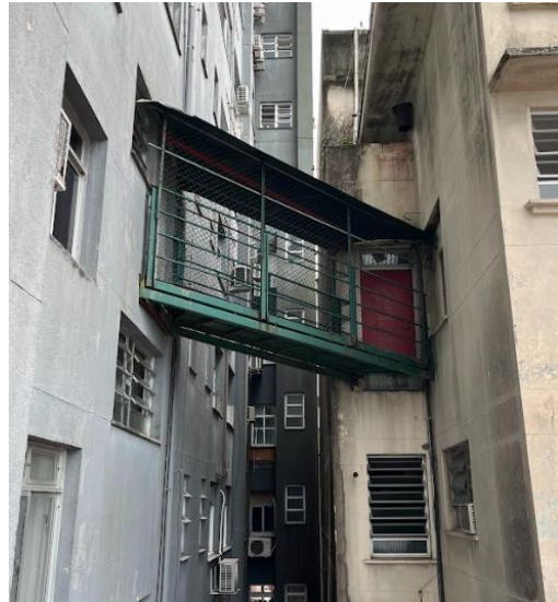
Figura 30 - Passarela de emergência 9º Andar
