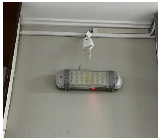
Figura 34 - Bloco autônomo área do corredor
