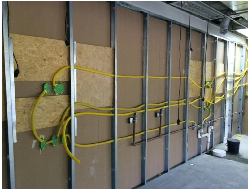
Figura 15 - Instalações embutidas no drywall
