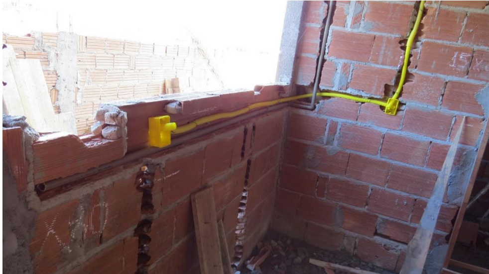
Figura 16 - Instalações embutidas na alvenaria em blocos cerâmicos
