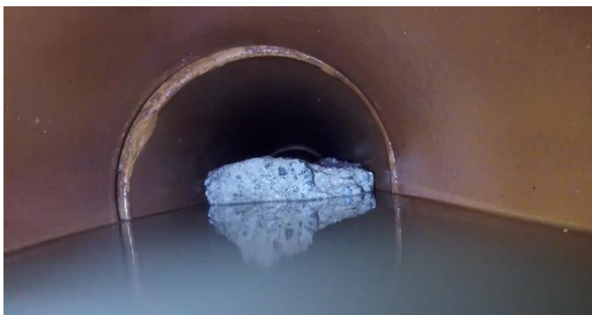
Figura 12 - Robô de inspeção interna em poço de visita.
