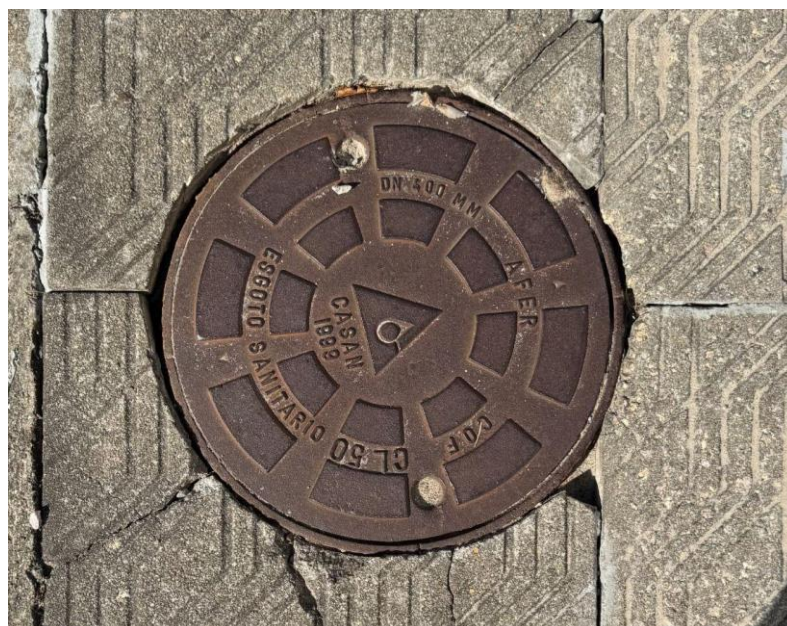
Figura 36 - CI no bairro Ingleses sem alças e juntas seladas
