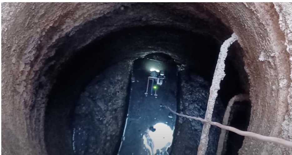
Figura 11 - Robô de inspeção interna em poço de visita.
