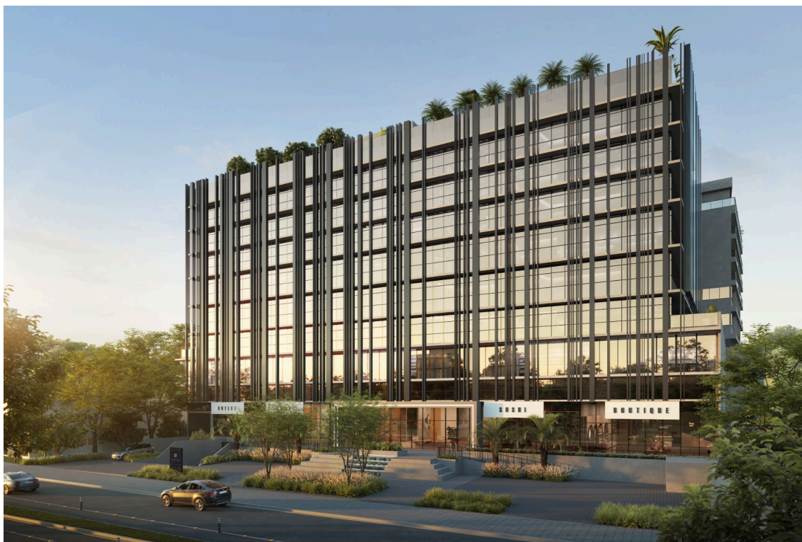
Figura 3 – Vista externa do edifício
