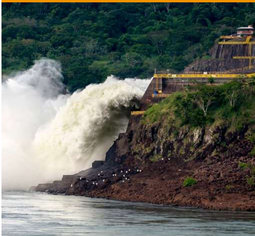
Usina Hidrelétrica de Itaipu – vertedouro. Foto: Rubens Fraulini / Acervo Itaipu Binacional
